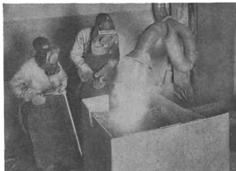
Abb. 51. Elektrische Warschweißung eines Maschinenständers.
