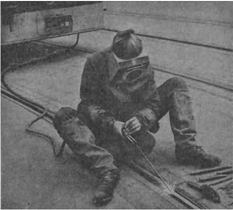
Abb. 12. Schweißer mit Schweißgerät (beim Schienenaufschweißen).
