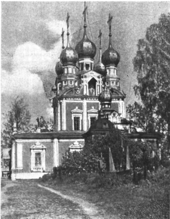
Рис. 3. Казанская церковь. Вид с юга
