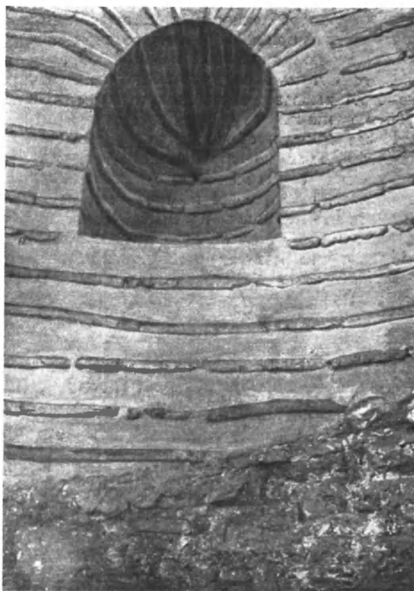
Рис. 10. Церковь Спаса на Берестове в Киеве. Часть стены внутри лестничного помещения
