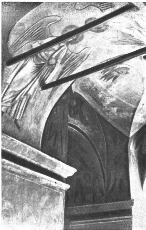
Рис. 7. Казанская церковь. Арки внутри входной части паперти
