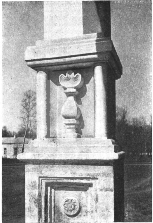
Рис. 5. Церковь Покрова в Измайлове. Столб крыльца
