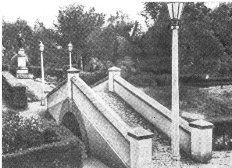
Мост через р. Бояка
