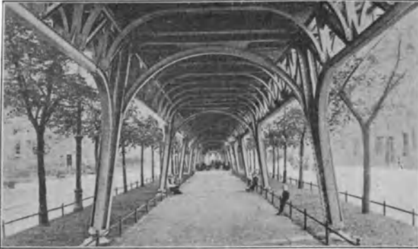
468. Berliner Hochbahn-Viadukt in der Bülowstraße.
