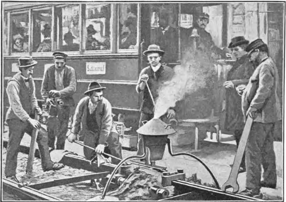
459. Vorrichtung zur Schienenschweißung nach Dr. Hans Goldschmidt.
