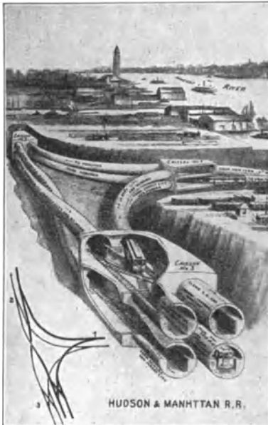
477. Tunnelausführung der Hudson und Manhattan Railway in New York.
