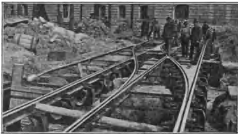
452. Einbau der unterirdischen Stromzuführung vor dem Brandenburger Tor in Berlin.
