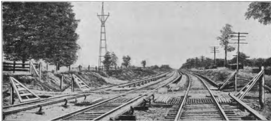
454. Straßenkreuzung einer Bahnanlage mit dritter Stromschiene.
