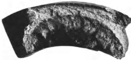
Abb. 25. Bruchfläche einer Vierkantspiraldruckfeder. Dauerbruch. V = 2.
