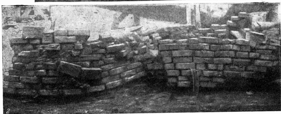
Рис. 47. Раскопки в Зарядье. Кирпичное производственное сооружение.
