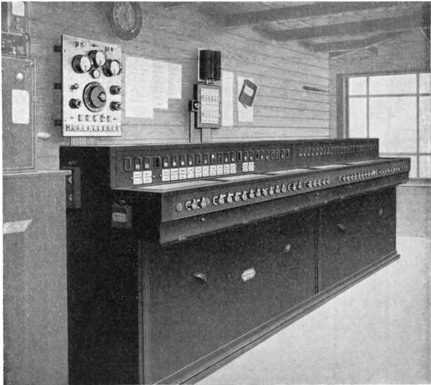
Abb. 308. Schaubild eines elektrischen Stellwerkes der Bauart Siemens & Halske.
