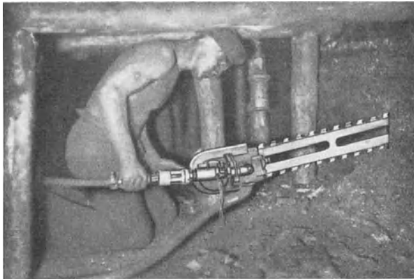
Abb. 163. Die Freihandschlitzmaschine oder Kohlensäge.
