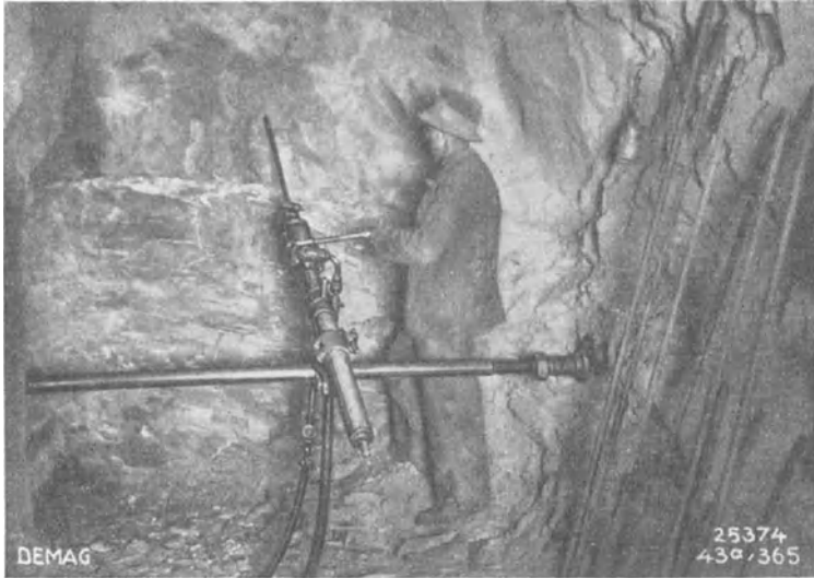
Abb. 196. Demag-Einspannvorrichtung.
