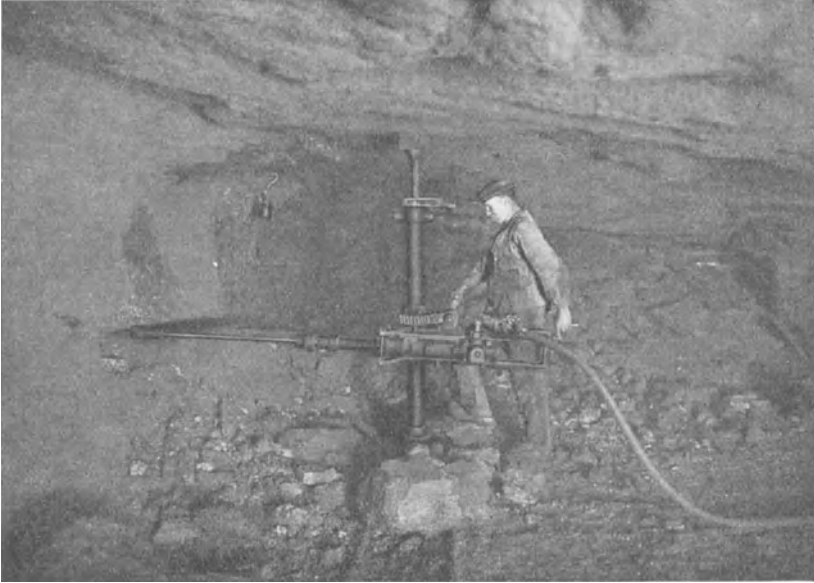
Abb. 166. Säulenschrämmaschine. Ausführungsform der Demag.
