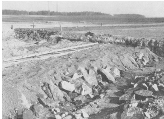
Abb. 79. Getrennter Einbau felsiger Massen und Sand.
