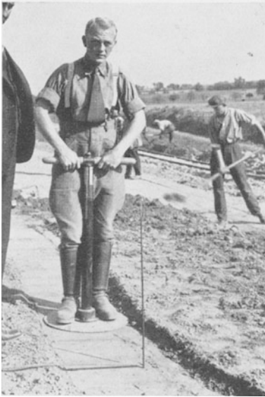
Abb. 81. Im Vordergrund der Prüfstab, dahinter der Dichteprüfer bei der Arbeit.
