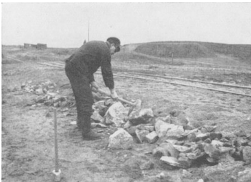
Abb. 75. Grobstückige, felsige Massen werden vor der Verdichtung zerschlagen.
