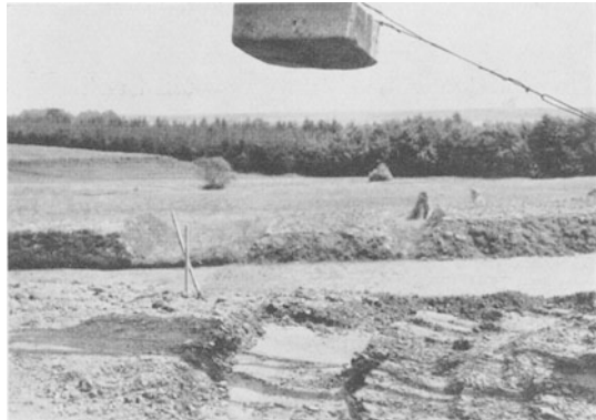
Abb. 97. Aufgeraute Schüttfläche (im Gegensatz zur Walzarbeit) bei Stampfplattenverdichtung.
