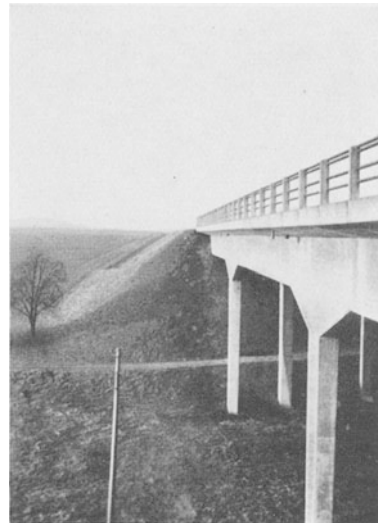
Abb. 131. Brücke ohne Widerlager.
