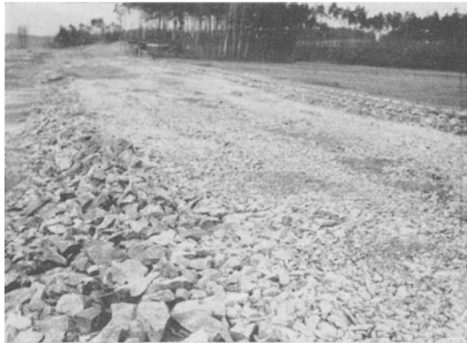
Abb. 76. Vorschriftsmäßige Zerkleinerung der Massen vor der Verdichtung.
