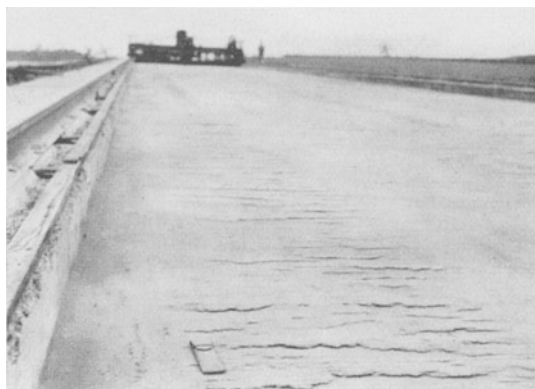
Abb. 21. Abscheren der obersten Bodenschicht durch Walzen.
