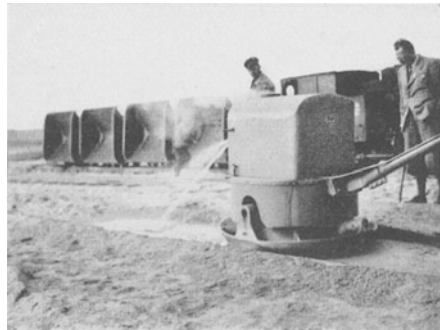
Abb. 118. Verdichtung von beweglichen Sandmassen durch Vibromax unter gleichzeitig starker Wasserzugabe.
