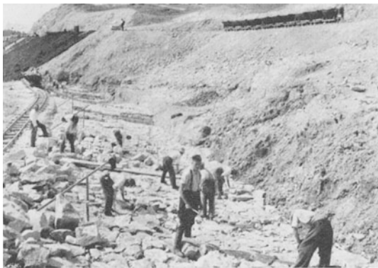
Abb. 172. Breite Stützmauer im Trockenmauerwerk als Sicherung gegen Rutschung.
