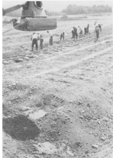
Abb. 96. Gewölbte Stampffläche des Stampfkörpers.
