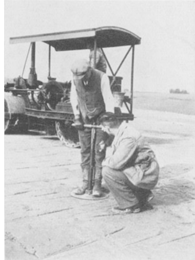
Abb. 127. Der Dichteprüfer im Betrieb.
