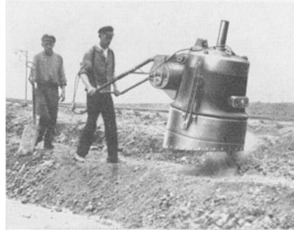
Abb. 104. 1000 kg-Ramme („schwerer Frosch“) (Aufnahme DEHMAG).
