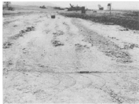
Abb. 106. Kreuzförmig abgerammte Schüttung.
