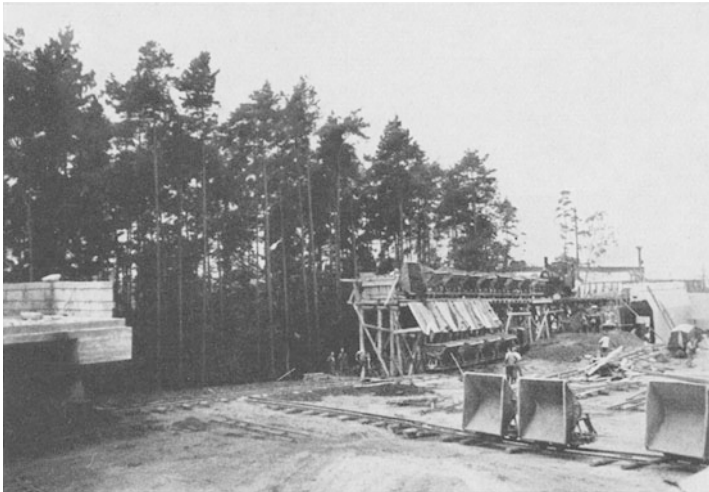
Abb. 49. Die Gerüstschüttung. Die Massen werden vom Gerüst durch Wagen zur Einbaustelle gebracht (starrer Förderbetrieb).
