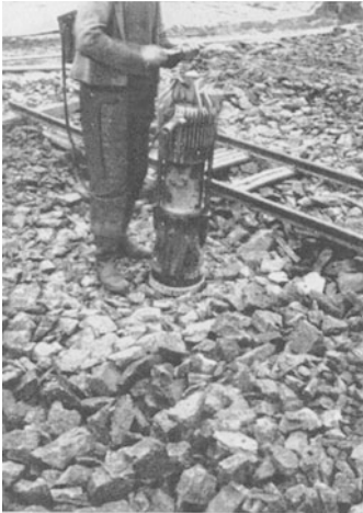
Abb. 103. 90 kg schwere Explosionsramme (falscher Einsatz, da Gestein zu grobstückig).
