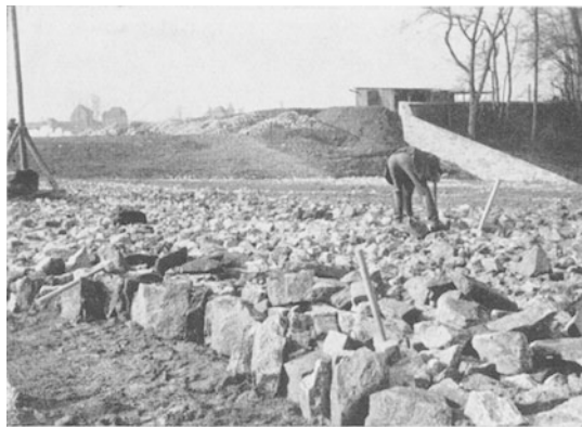
Abb. 77. Packlageartiger Einbau felsiger, fester Gesteinsbrocken.
