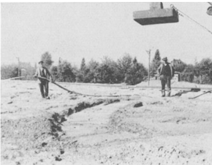
Abb. 117. Verdichtung mittels Stampfplatte unter gleichzeitigem Einsümpfen der beweglichen Sandmassen.
