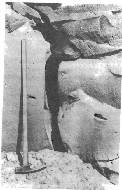
Р и с. 34. Трещины отрыва в базальтах долины р. Орхона (МНР)
