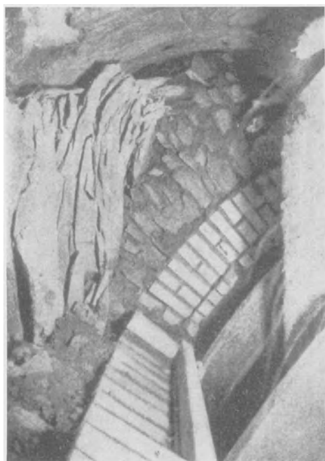
Abb. 35. Bergschläge bei km 9,672 ab N. P. im zweiten Simplontunnel (nach Andreae).
