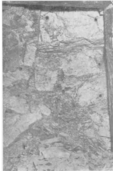
Abb. 48. Stollenbrust in scheinbar standfestem Glimmerschiefer. In diesem Gebirge äußerte sich trotz der scheinbaren Standfestigkeit kräftiger, echter Gebirgsdruck, der die Auskleidung zerdrückte (nach Heilbrunner).
