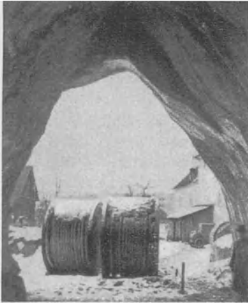
Abb. 2 a. Ausbildung keilförmiger Druckkörper in den Melker Sanden (nach Schädler).
