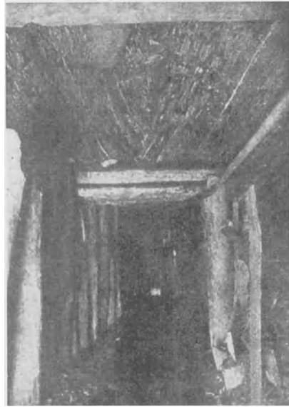
Abb. 29. Ausquetschen des gezogenen Körpers in der Firste (nach Müller).
