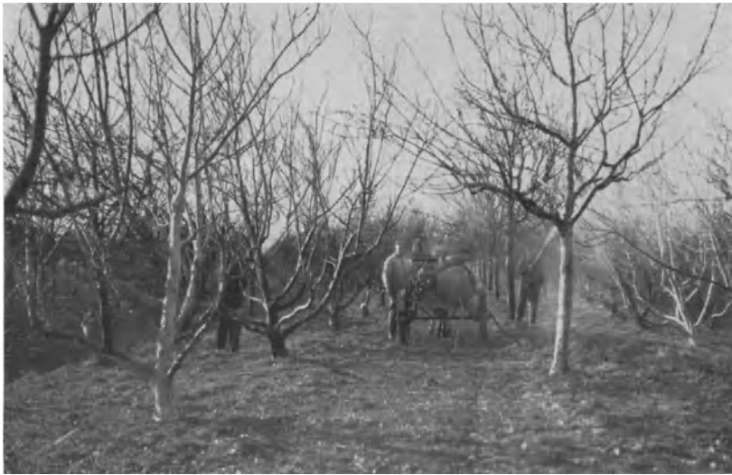
Abb. 57. Motorspritze in jüngerer Apfelanlage. Es wird gleichzeitig mit zwei kurzen Rohren Obstbaumkarbolinum verspritzt.
