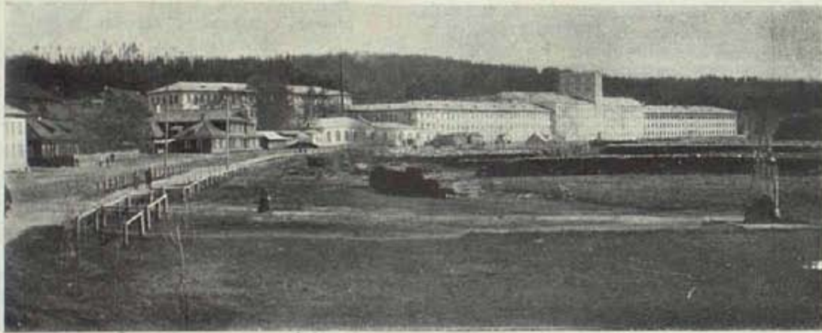
Общій видъ суконной фабрики А. Д. Протопопова.
