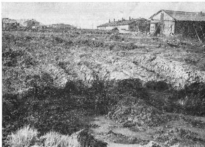
РИС. 9. Такова судьба грунтовых дорог в условиях вечномёрзлых пород, пронизанных жильными льдами. В обнажении под слоем минерального грунта виден лёд
