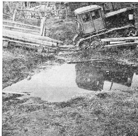
РИС. 10. Поселок, построенный в 50-х годах без учёта подземных жильных льдов. Их протавивание ведет к образованию просадок, оврагов, термокарстовых озёр. В результате деформации поверхности земли разрушаются дома, грунтовые дороги
