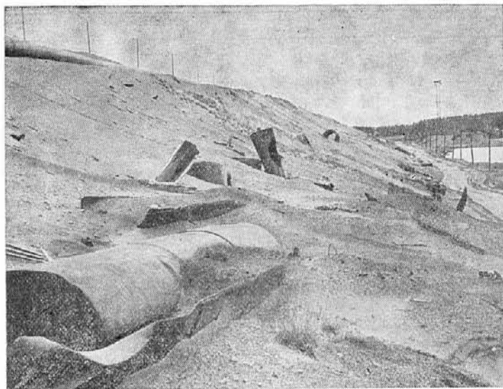
РИС. 44. Так выглядит один из участков хвостохранилища, не засеянный травами. Вверху — действующий пульпопровод; на первом плане — остатки ранее действовавшего пульпопровода. Тело хвостохранилища засорено трубами, бревнами, проволокой, бочками и т. д. Если их не убрать, то в дальнейшем трудно будет разрабатывать это хвостохранилище как залежь минерального сырья
