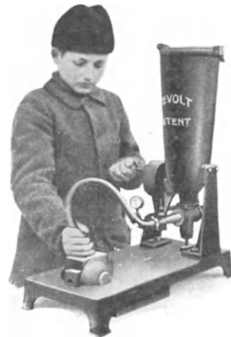
Abb. 1702. Die Preßluftkernspritze „Revolt“ in Tätigkeit.
