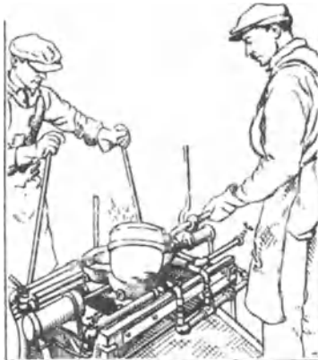
Abb. 1668. Gießen in Dauerformen.
