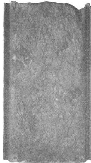
Abb. 691. Rückseite einer Ofenplatte mit Seitenleisten.
