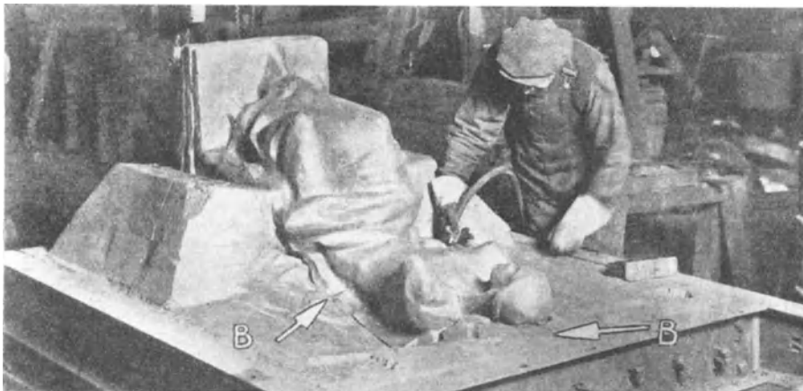
Abb. 715. Ausblasen der getrockneten Form.
