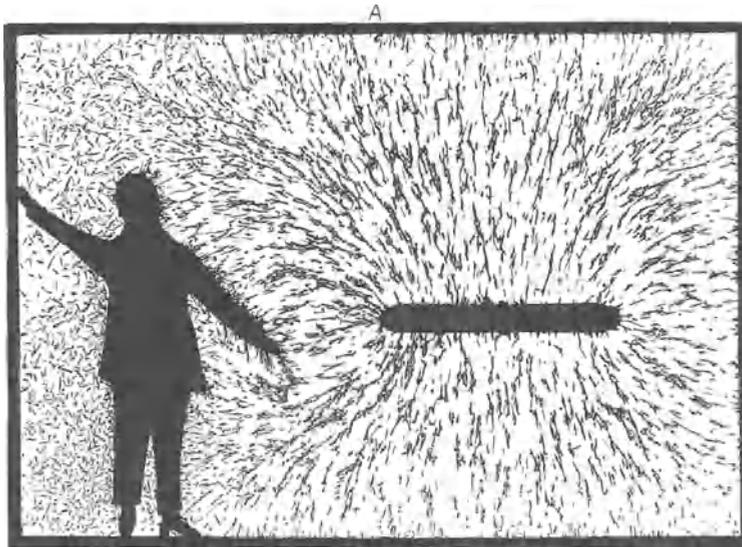
Abb. 41. Elektrische Feldlinien zwischen einem altertümlichen „Elektrizitätsträger“ („Konduktor“) und der Umgebung. Man beachte ihre Veränderung durch die Bewegungen des Experimentators.
