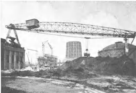
Abb. 234. Fahrbarer Brücken-Kabelkran zur Bedienung des Kohlenlagers und der Kohlenbunker eines Kraftwerkes (Spannweite 64 m, Tragkraft 5 t; Ausführung: Bleichert).
