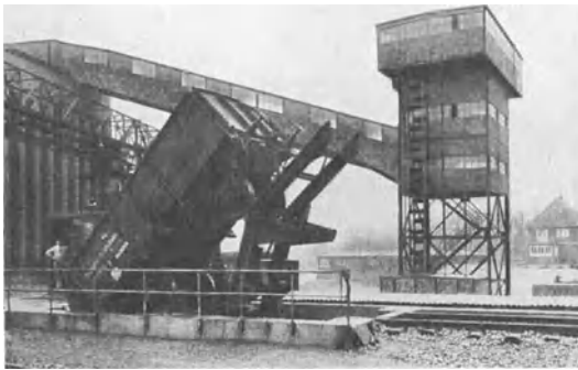
Abb. 239. Wagenkipper, Becherwerk, Übernahmeturm und Gurtförderer.
