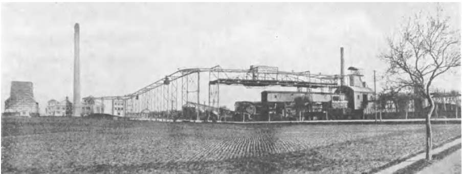
Abb. 230. Kohlenförderung von der Grube zum Kraftwerk mit Elektro-Hängebahn (Bleichert).
