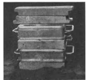
Abb. 9. Gießfertige Form.
