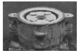
Abb. 68. Mittel- und Unterkasten nach Herausnahme des Modelles.
