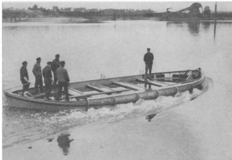
Abb. 14. Das mit einem Eisengewicht entsprechend 145 Personen belastete und voll Wasser gefüllte Boot macht mit dem eingekapselten, unter Wasser befindlichen Motor eine Fahrt.
