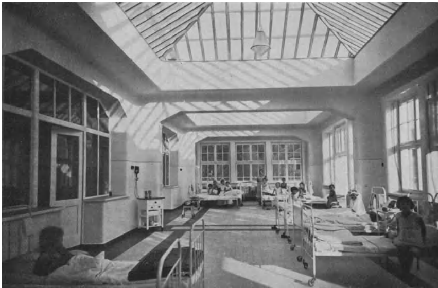
Abb. 30. Eine der Winter-Lichthallen der Kaiser Wilhelm-Tuberkulosekinderklinik bei Landeshut (Rgb.). * Korridorseite. † Schiebefenster, z. T. bis zum Boden, mit Ausgang auf die vorgelagerten Sonnenterrassen.
