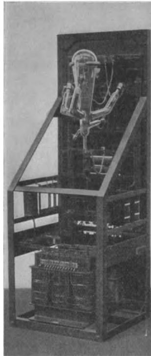
Abb. 83. Rückseite des Quecksilberdampfgleichrichters VDA 25 und VDA 40.
