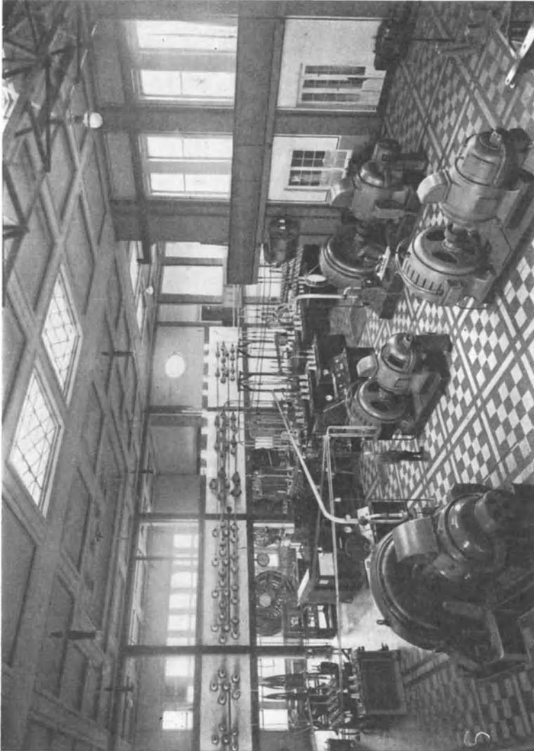
Abb. 138. Maschinensender der Großfunkanlage in Nauen.
