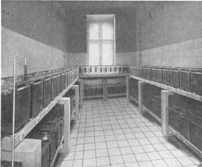
Abb. 29. Sammlerraum einer automatischen Fernsprechanlage der Berliner Straßenbahn.
