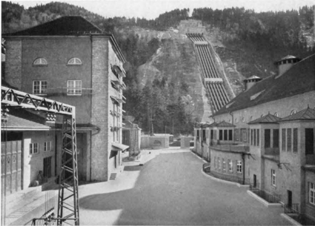
Bild 100. Werkhof und Wasserwiderstände.
