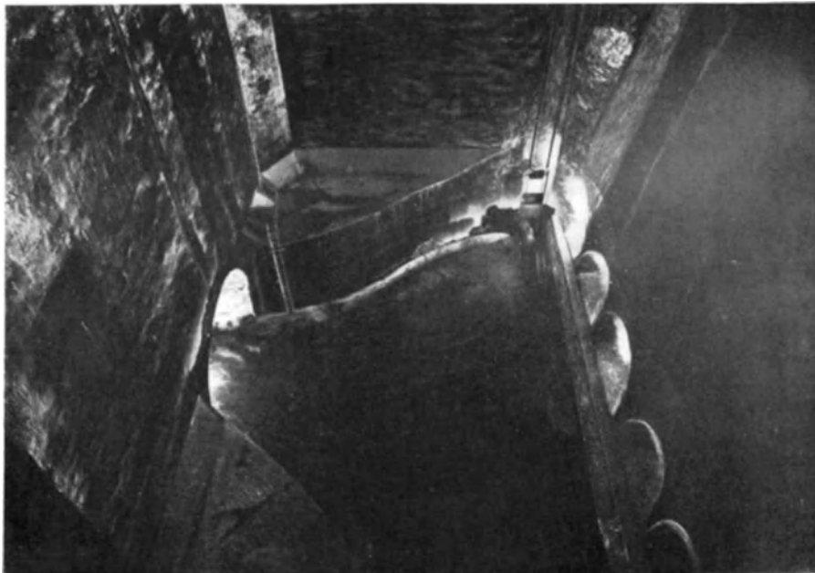
Bild 73a. Tiefblick in das Wasserschloß. (Von der Galerie aus gesehen; links Stollenmund, rechts Rohreinläufe, in der rechten hinteren Ecke Entleerungsschleuse.)
