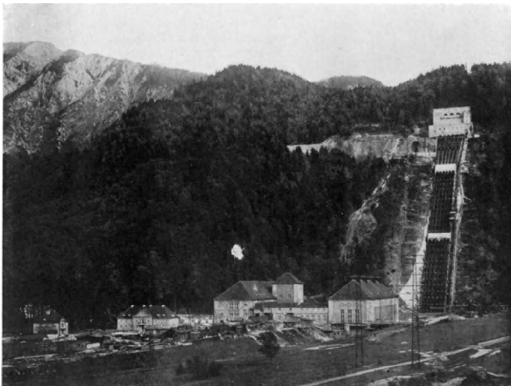
Bild 68. Kraftwerk, Rohrbahn und Wasserschloß.
