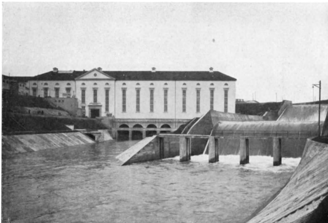
Bild 111. Kraftwerk Aufkirchen (Ansicht vom Unterwasser aus). Höhe des Gebäudes von der Sohle des Unterwasserkanals bis zum Dachfirst 38 m. Unten die Gewölbe der Saugrohrkammern. Unter dem Giebelbau Einfahrtstor für den normalspurigen Gleisanschluß zum Abstellraum. Rechts Leerschuß mit 2 künstlichen Kolken hintereinander als Energievernichter.
