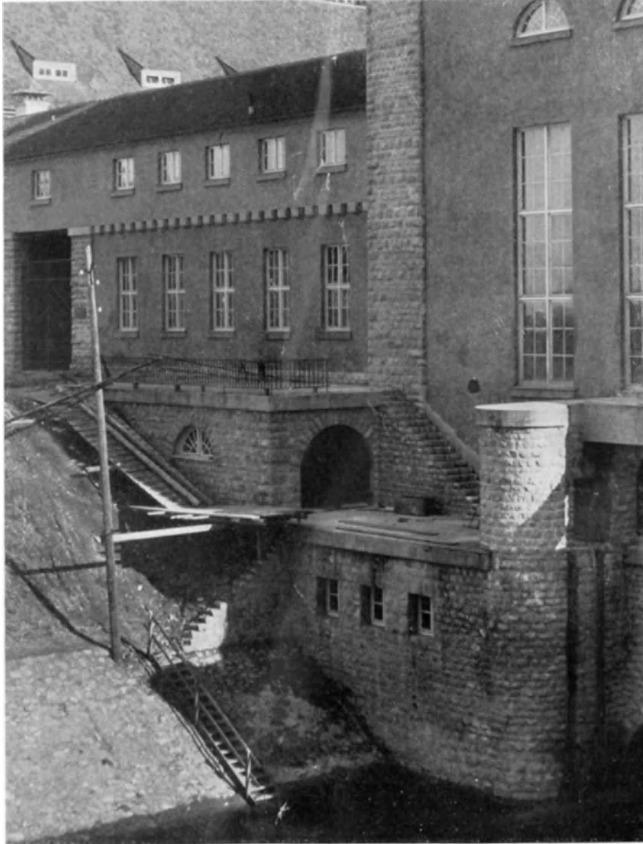
Bild 98. Pumpen- und Dammbalkenhaus (Außenansicht).
