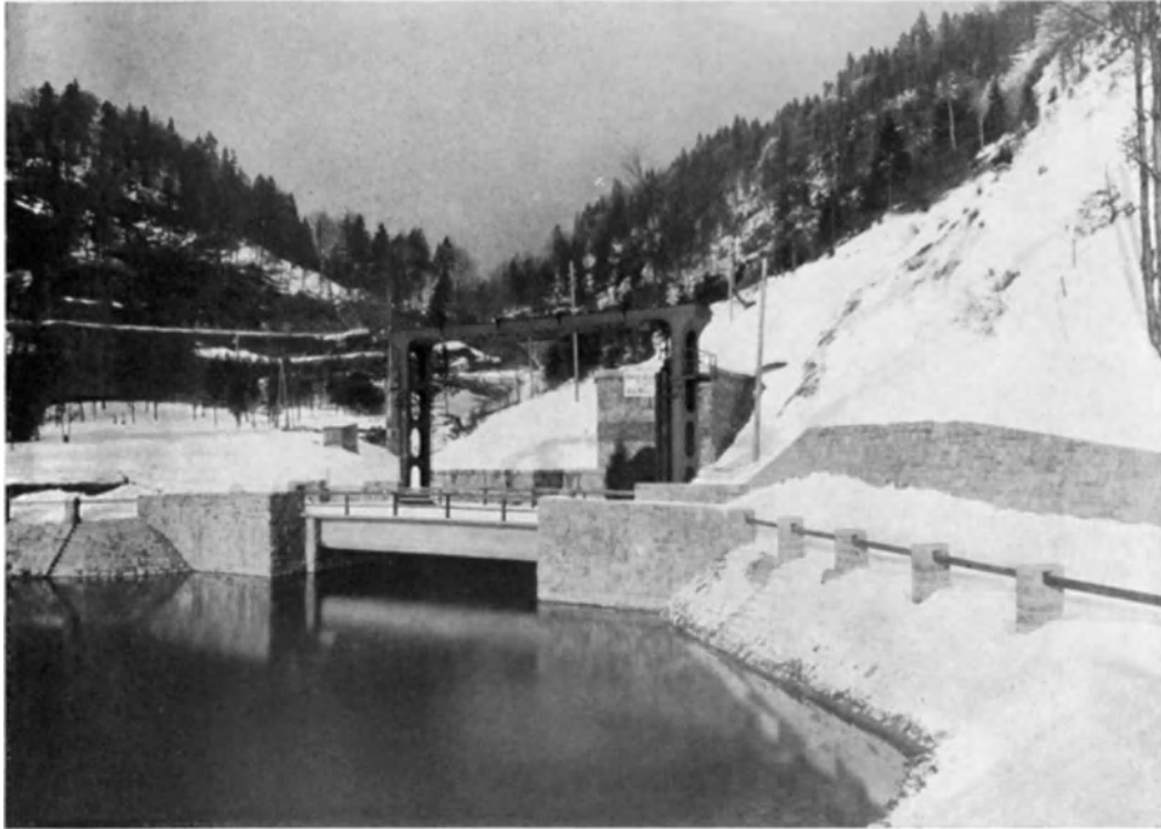
Bild 65. Einlaufbauwerk Urfeld. Gesamtansicht.
