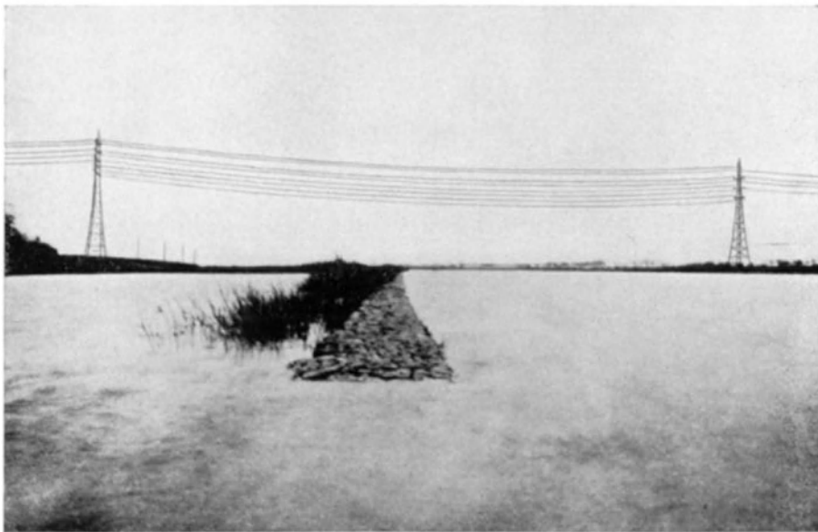
Bild 8a und 8b. Donaukreuzung (Turmhöhe 50 m).
