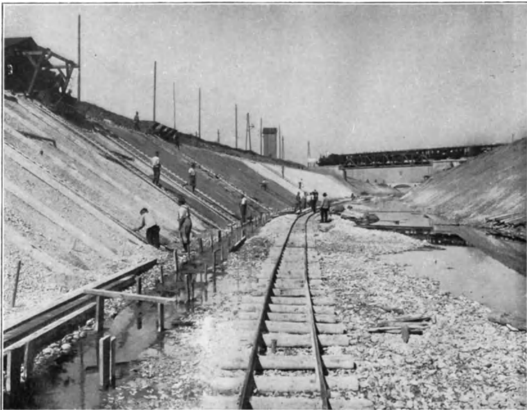
Bild 113. Betonieren der Böschung des Kanals bei km 5,2.
