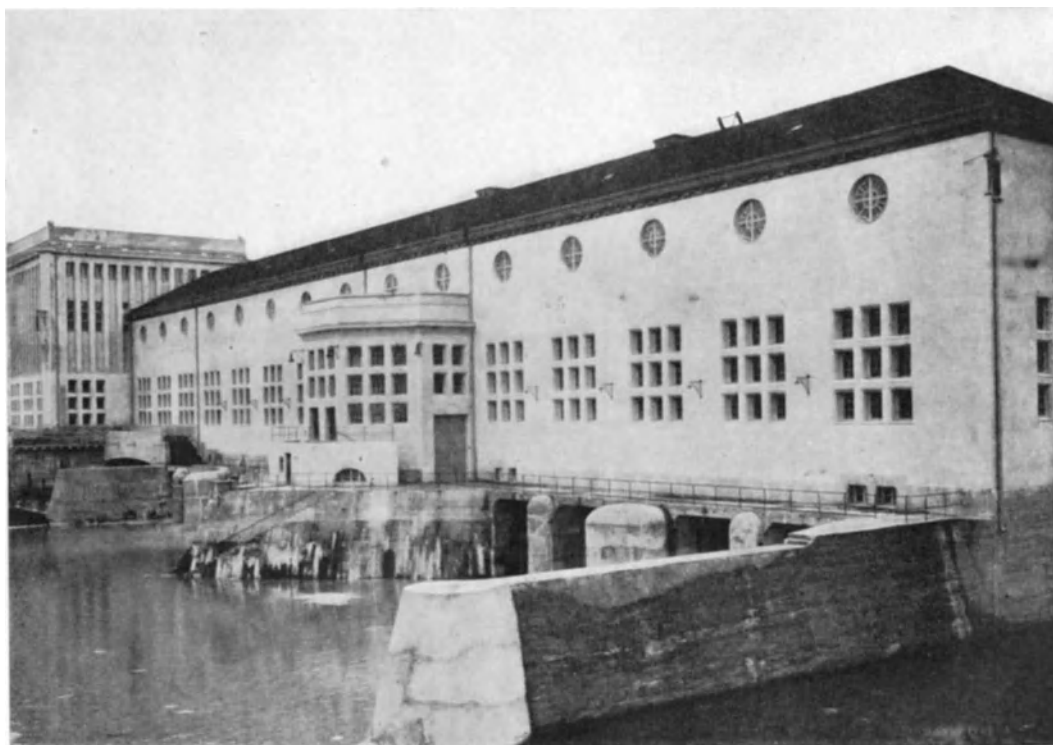
Bild 109. Kraftwerk Finsing (von der Unterwasserseite). Mittleres Nutzgefälle 11 m; Höchstleistung des Werkes 14200 PS a. d. Turbinenwelle bei 125 cbm/sec Wasserführung. Länge des Maschinenhauses 106 m, im Turmbau (links) Betätigungsraum und Haupt- befehlstelle für die Lastverteilung aller Kraftwerke der Mittleren Isar.
