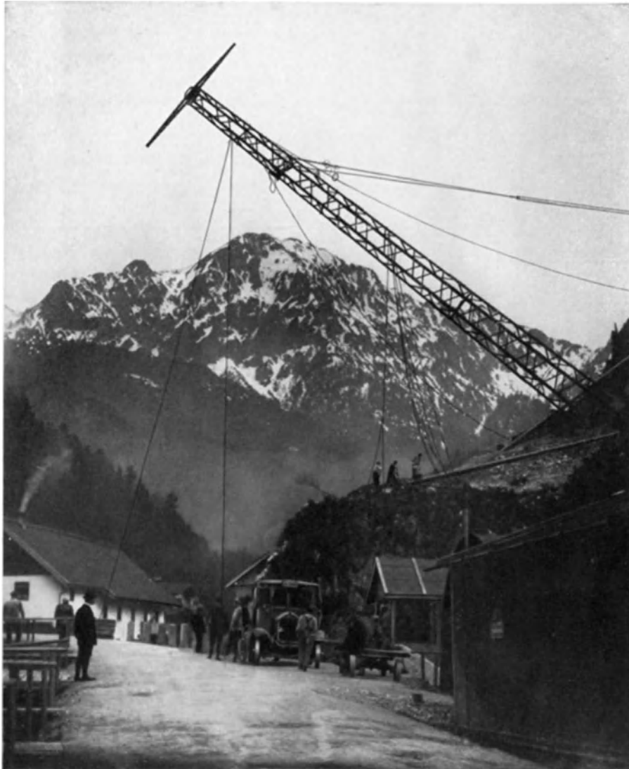
Bild 20. Aufstellen eines Abspannmastes in Altjoch.
