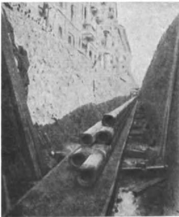
Abb. 397. Steingutrohranlage für die Erweiterung des Mailänder Telephonkabelnetzes im Bau (Pirelli).
