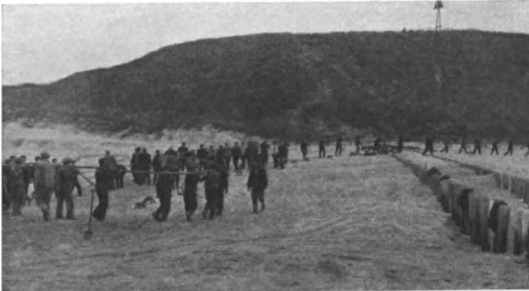
Abb. 419. Verlegung des 159 km langen Telephonkabels zwischen Holland und England.
