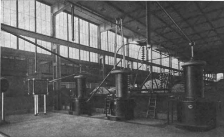
Abb. 374. Einphasenbelastungstransformatoren von Ferranti, gegen Erde für 150 kV isoliert (St. E. C.).
