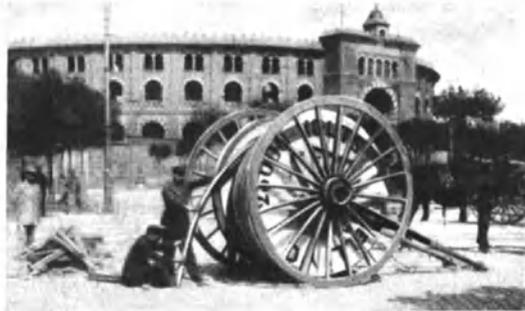
Abb. 412. Einziehen eines Hochspannungskabels (Pirelli).
