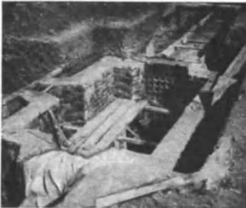
Abb. 399. Steingutrohranlage für die Erweiterung des Mailänder Telephonkabelnetzes im Bau (Pirelli).
