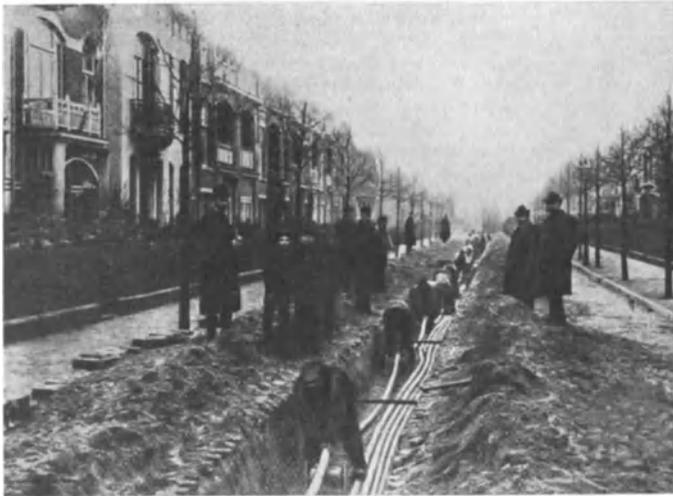
Abb. 390. Verlegung von Telephon-Erdkabeln (F. & G.).
