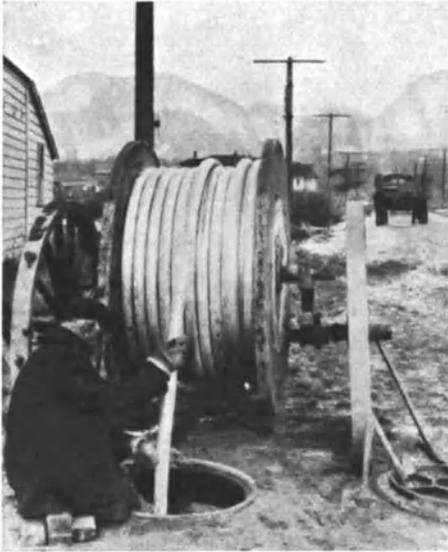
Abb. 413. Einziehen eines Telephonkabels. Einlauf des Kabels in den Brunnen (ATTC).
