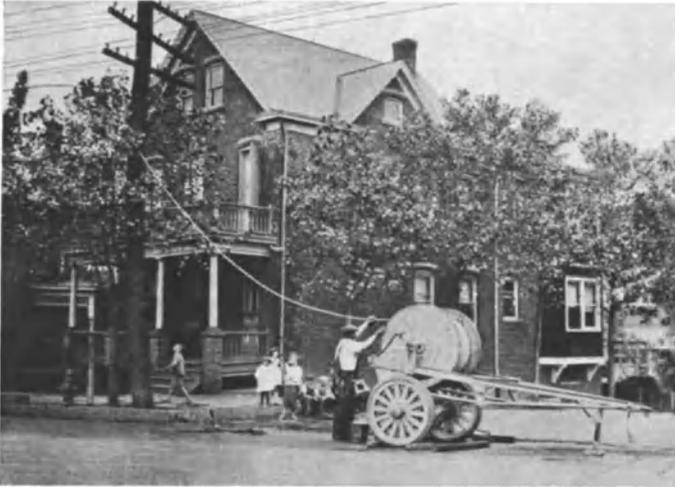
Abb. 434. Luftkabelmontage in Amerika: Ablauftrommel auf einem Kabeltransportwagen (ATTC).
