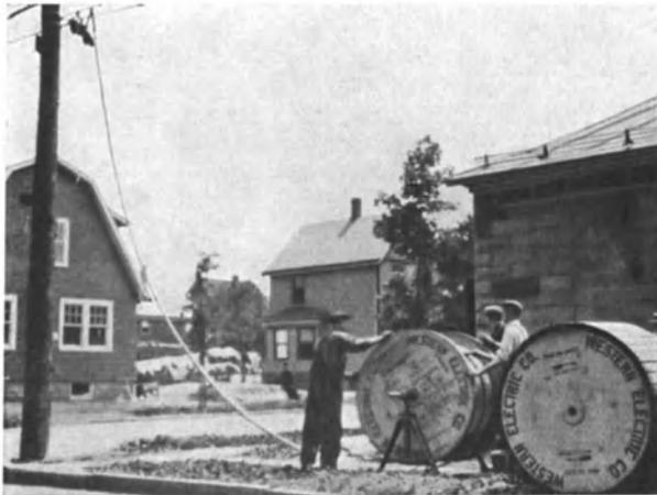
Abb. 433. Luftkabelmontage in Amerika: Aufstellung der Ablauftrommel auf Böcke (ATTC).
