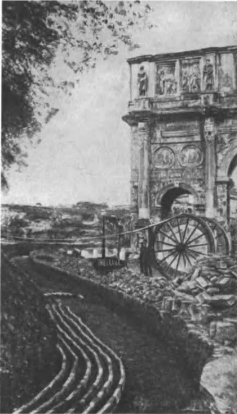
Abb. 389. Verlegung von Starkstrom-Erdkabeln.
