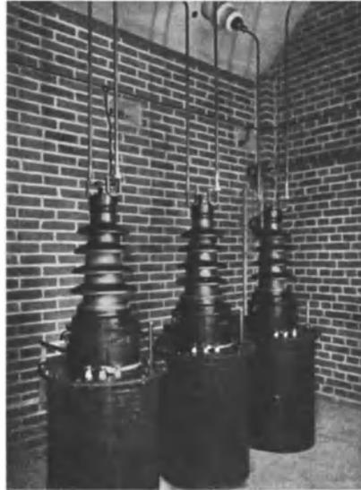
Abb. 472. Schutzwandler des Pfannkuch-Kabelschutzsystems (AEG).
