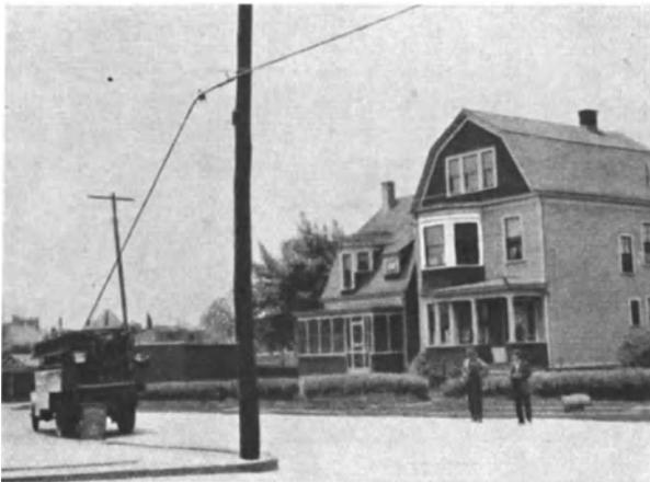
Abb. 435. Luftkabelmontage in Amerika: Hochziehen des Kabels mit Zugseil und Motorwinde (ATTC).
