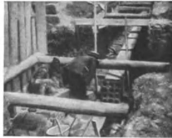
Abb. 400. Steingutrohranlage für die Erweiterung des Mailänder Telephonkabelnetzes im Bau (Pirelli).
