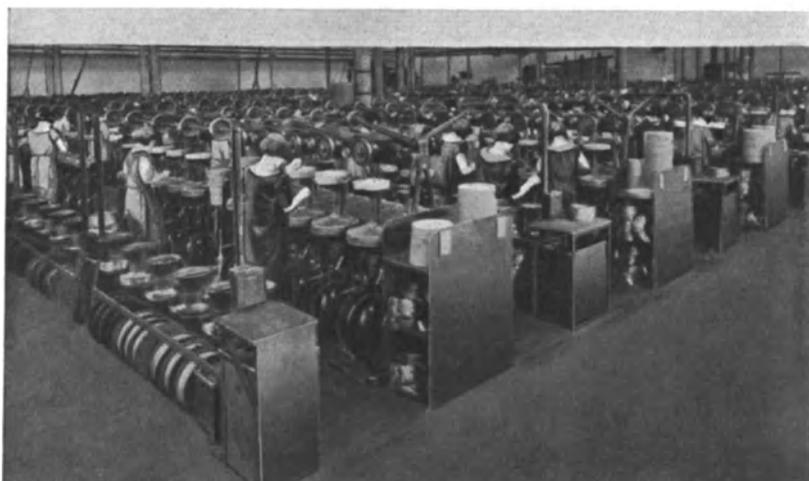
Abb. 229. Fünfgängige Isoliermaschinen für Telephonkabeladern im Kabelwerk Hawthorne (WEC).
