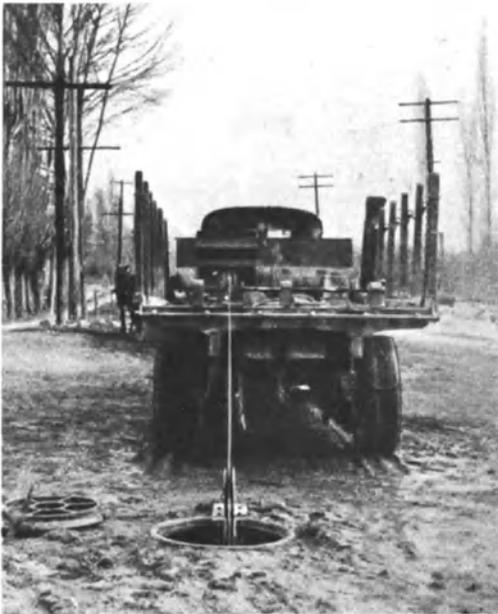
Abb. 414. Einziehen eines Telephonkabels. Lastauto mit Winde und Zugseil (ATTC).
