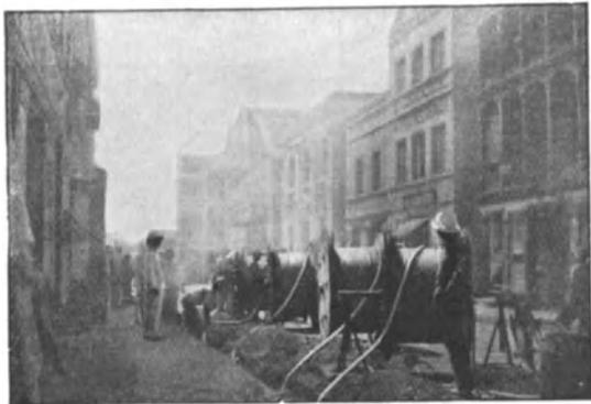
Abb. 391. Aufstellung der Trommeln bei der Verlegung von mehreren Kabeln in einem Graben (F. & G.).
