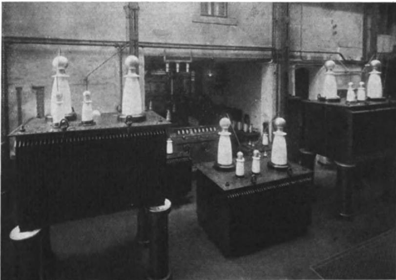
Abb. 346. Transformatorenaggregat für das Hochspannungsprüffeld eines Kabelwerkes (K. & St.).
