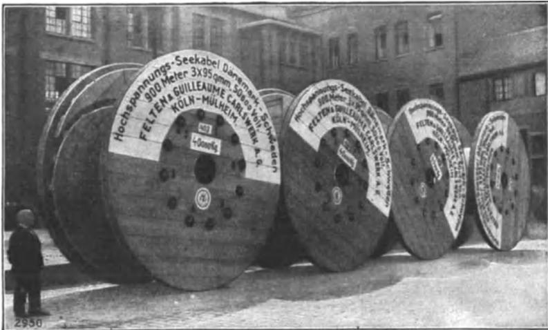
Abb. 383. Trommeln von 4 m Durchmesser für den Transport der Sund-Kabel (F. & G.).
