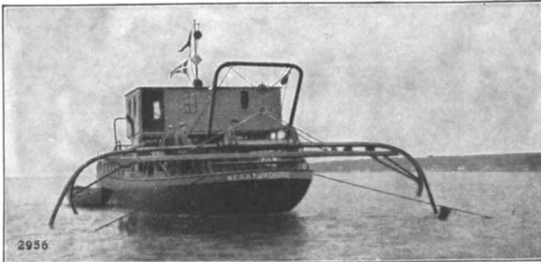
Abb. 445. Montage der  $3 \times 50$  kV-Seekabelmuffe von F. & G. Versenkung der Muffe.
