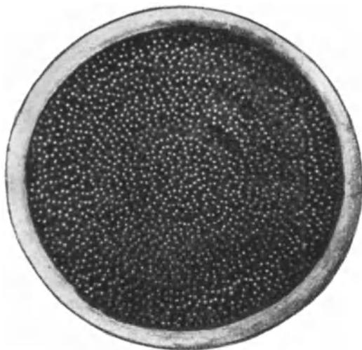
Abb. 140. 909-paariges Kabel mit 0,64 mm starken Kupferdrähten (ATTC.).
