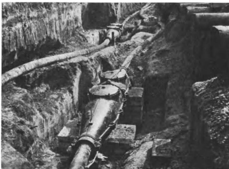
Abb. 447. Blei-Eisen-Verbindungsmuffen für  $3 \times 60$  kV (AEG).
