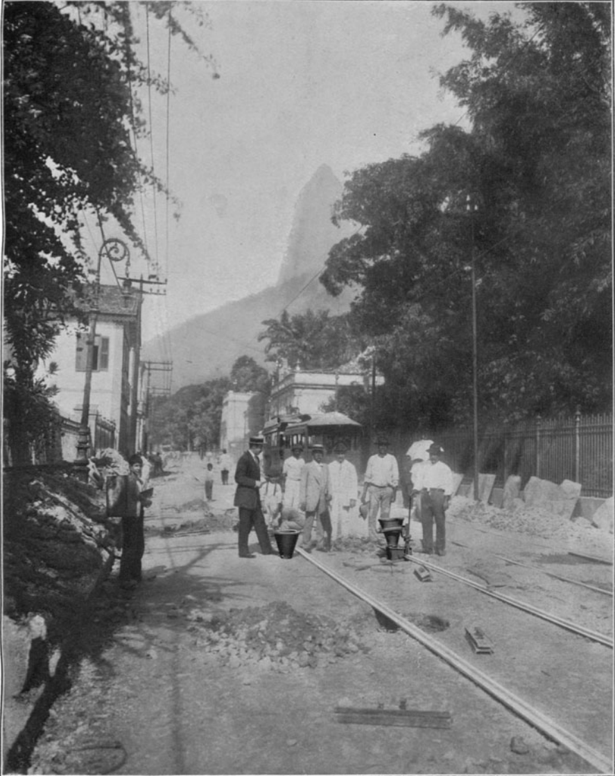
Schweißung von Straßenbahnschienen in Rio de Janeiro
