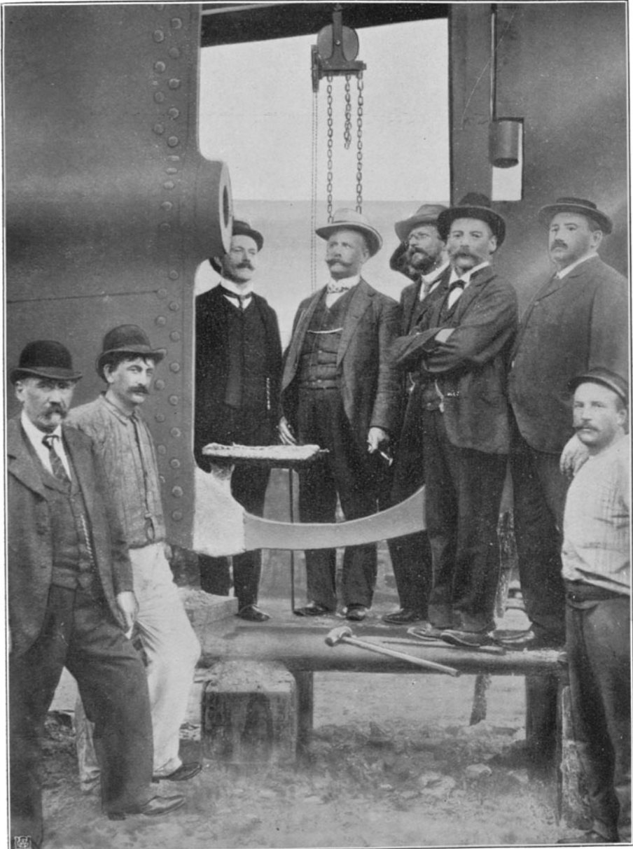
Abb. 71. Geschweißter Achtersteven des Dampfers „Sebenico“
