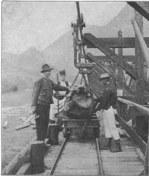
Abb. 39. Das Entladen geschieht entsprechend dem Beladen, siehe Abb. 38. (Bauart Bleichert.)
