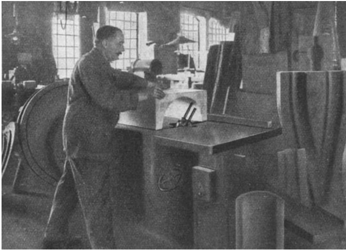
Abb. 528. Kernkastenfräsmaschine für Modelltischlereien. (Franz Küstner, Dresden-N.)
