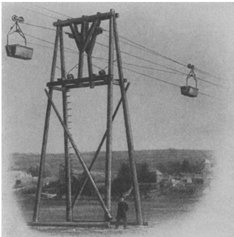
Abb. 25. Holzstütze für Drahtseilbahnen.
