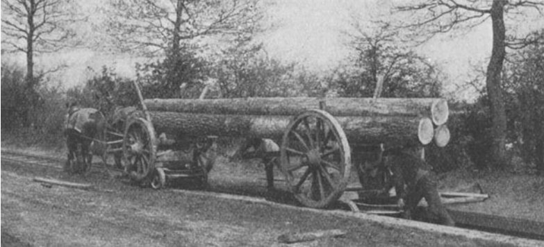
Abb. 45. Fuhrwerksbahn in dem Gräfl. Bernstorffschen Forstamt. Das Auffahren des mit Stämmen beladenen Landwagens auf die Transporteure [Trucks]. (Orenstein & Koppel A.-G., Berlin.)
