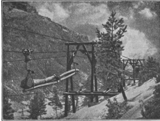
Abb. 41. Bleichertsche Drahtseilbahn für Holzförderung im verschneiten Hochgebirge.
