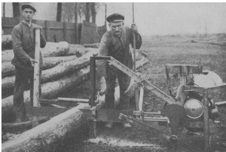
Abb. 85. Tragbare Fuchsschwanz-Abkürzsäge. (H. Rhein, Bad Hersfeld.)
