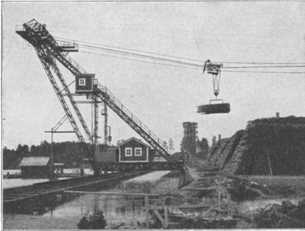
Abb. 62. Einer der drei Kabelkrane der Strömsbruks Aktiebolaget, Sulfittfabrik, Strömsbruk (Schweden) für Holzförderung und Stapelung. (A. Bleichert & Co., Leipzig.)
