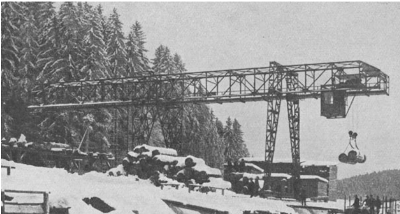
Abb. 69. Verladebrücke für Holz von 2,5 t Tragfähigkeit und 11,85 m Stützweite. Ernst Petzold jr., Spiegelau, Bayr. Wald. (Erbaut von der Maschinenfabrik Augsburg-Nürnberg A.-G.)
