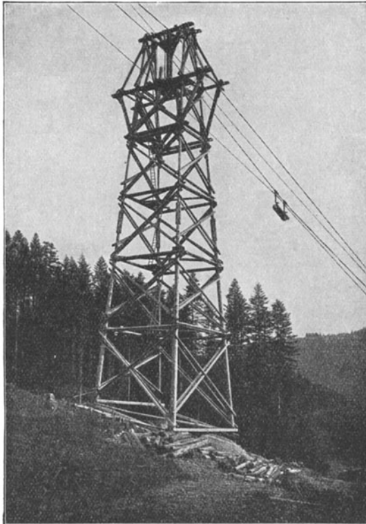
Abb. 42. Eine Bleichertsche hölzerne Portalstütze von 45 m Höhe einer Holzdrahtseilbahn in Oberösterreich von 9,5 km Länge.
