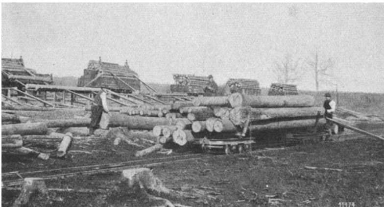
Abb. 53. Umladen von Stammholz von den Doppeltruckwagen in Güterwagen in den Fürstl. Pleißchen Forsten. (Orenstein & Koppel A.-G., Berlin.)
