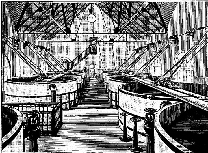
Рис. 1. Фильтровальная станция на 175.000 куб. м (1.400.000 ведер) воды в сутки в г. Ниагара Фалльс, штата Нью-Йорк.
