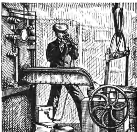
Abb. 268. Temperaturmessung des Abstichs mit Wannerpyrometer.
