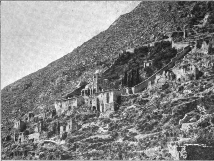
Abb. 56. Das Pantanassakloster, von Nordosten.
