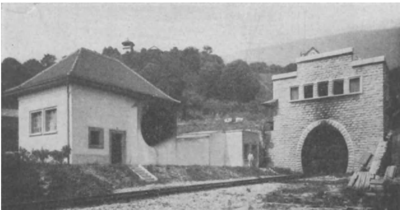
Abb. 152. Ventilatoranlage für den Grenchenbergtunnel.
