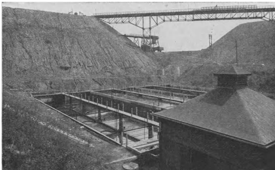
Abb. 36. Mammut-Bagger für Kohenschlamm aus Klärbecken der Gelsenkirchener Bergwerks-A.-G.
