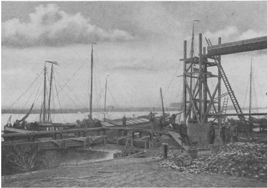
Abb. 35. Rübenhebung aus Schiffen mittels Mammutpumpe in der Zuckerfabrik „de Klingelbeek“.
