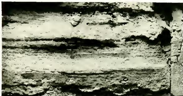
FIG. 192. LIMESTONE BLOCKS IN EAST LIGHT-WELL OF 'QUEEN'S MEGARON' SHOWING WIND EROSION.
