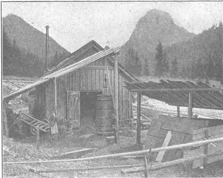
Abb. 424. Destillationshütte zur Gewinnung von Latschenkieferöl in Tirol.
