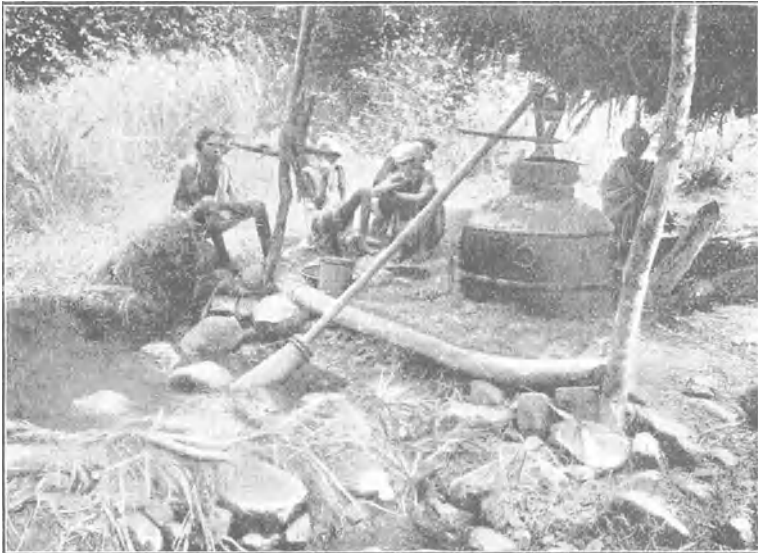
Abb. 420. Destillation von Palmarosaöl im Bezirke Kandesch.
