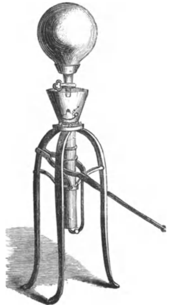
Fig. 143. Verbesserte Form der ersten Luftpumpe.
