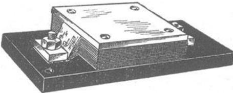
Abb. 8. Gelegter Festkondensator der Birgfeld-Broadcast A.-G.
