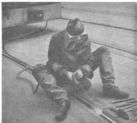
Fig. 13. Schweißer mit Schweißgerät (beim Schienenaufschweißen).
