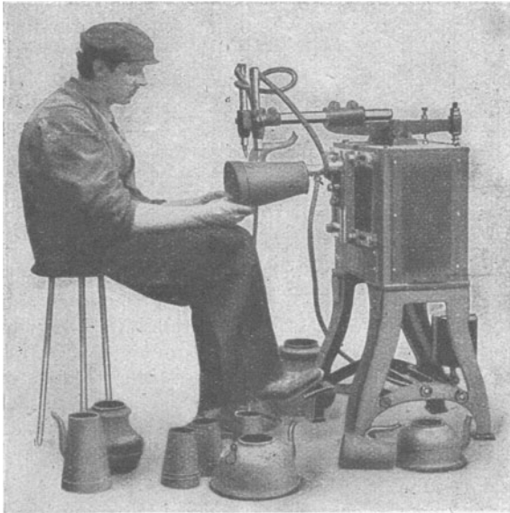
Fig. 18. Elektrische Punktschweißmaschine mit Doppel­elektroden.
