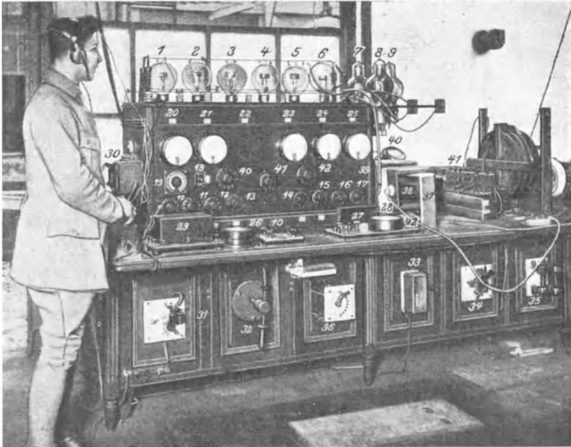
Abb. 68. Ansicht des Telephonieröhrendesertisches der Eiffelturmstation.
