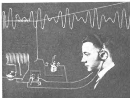
Abb. 26. Radiotelephonie-Empfangsstation. Die im Rhythmus der Sprachschwingungen modulierten Hochfrequenzschwingungen erregen den Empfänger. (Aus „The Wireless Age“.)
