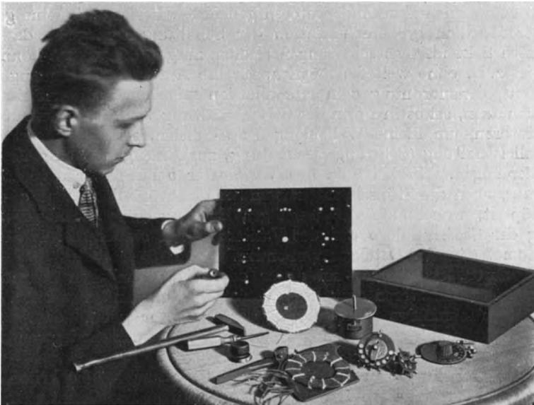
Abb. 335. Zusammensetzen eines Amateurempfängers.
