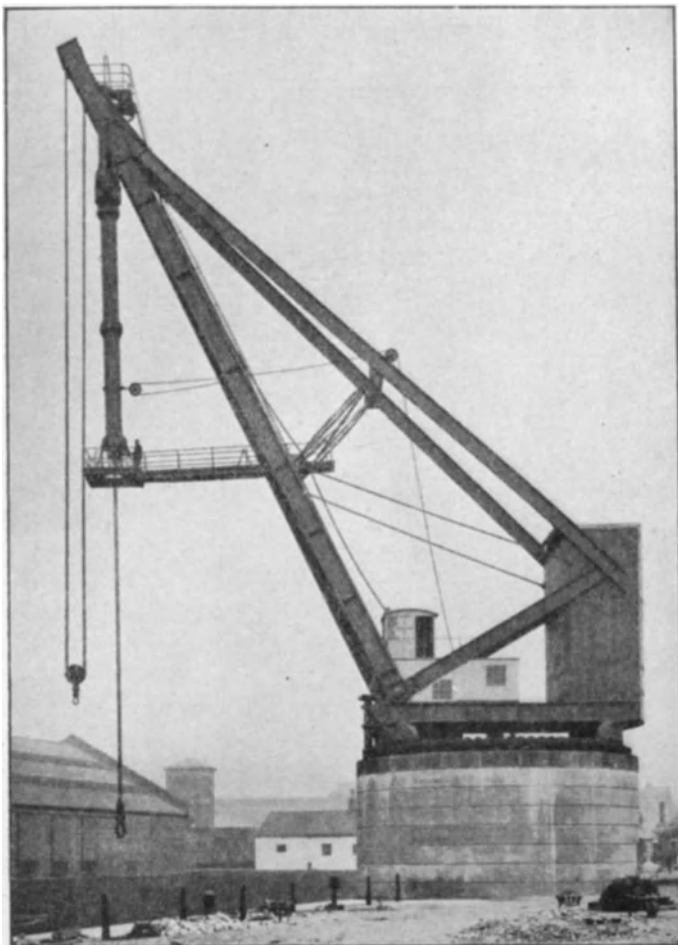
Abb. 675. Direkt wirkender Druckwasserkran (Liverpool).
