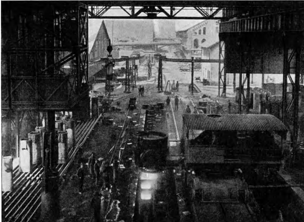
Abb. 294. Elektrohydraul. Gießwagen und elektr. Stripper (Burbach).
