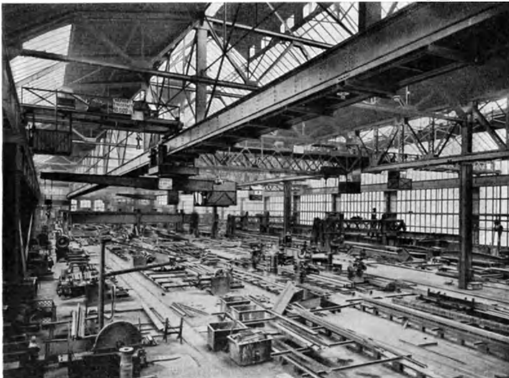
Abb. 509. Krananordnung in einer Eisenbauwerkstatt (Witkowitz).
