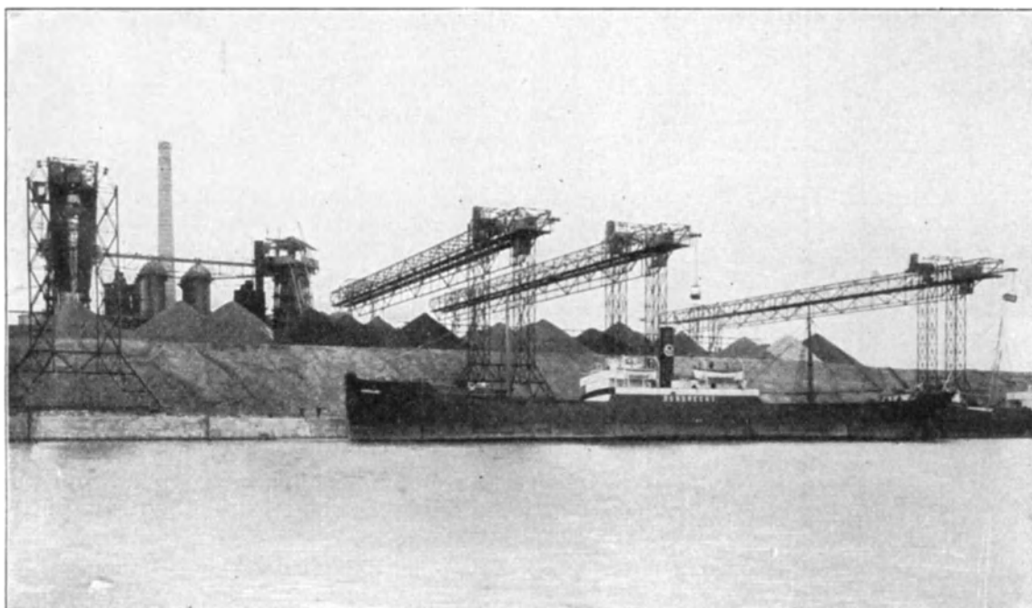
Abb. 32. Schiffsentlade- und Lagerplatzbrücken (Lübeck).
