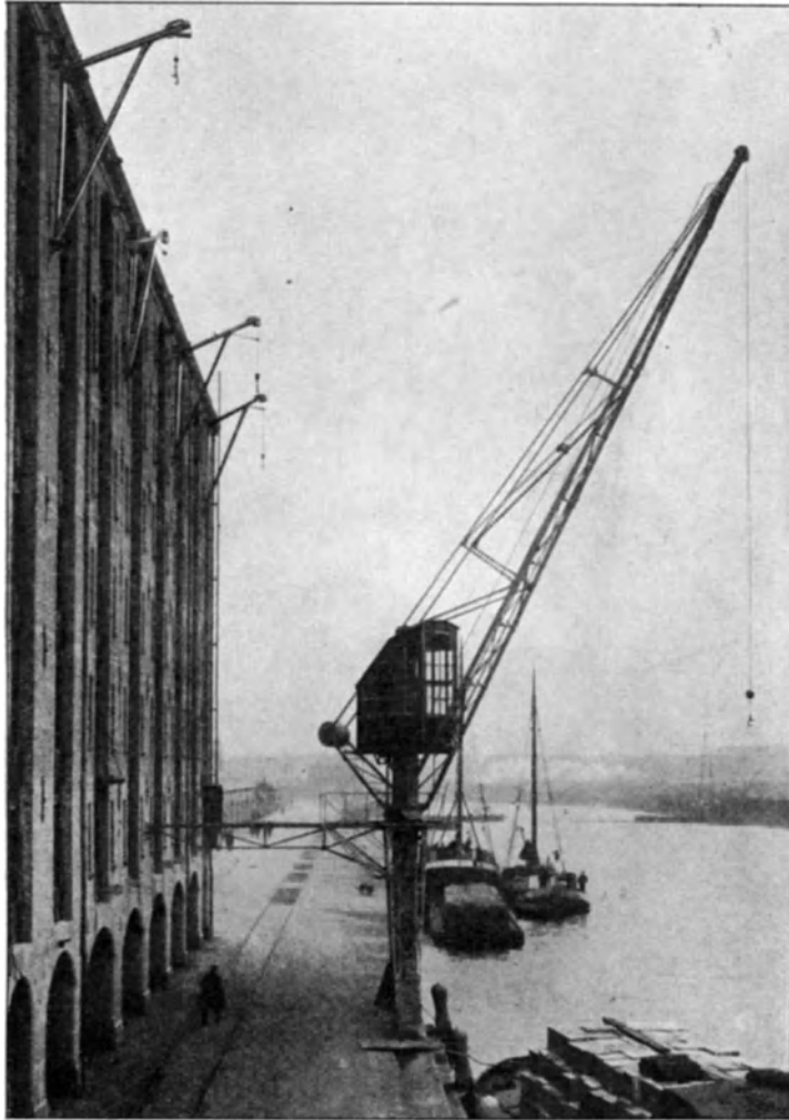
Abb. 862. Schiffsentladekran und Speicherbeladearme (Amsterdam).
