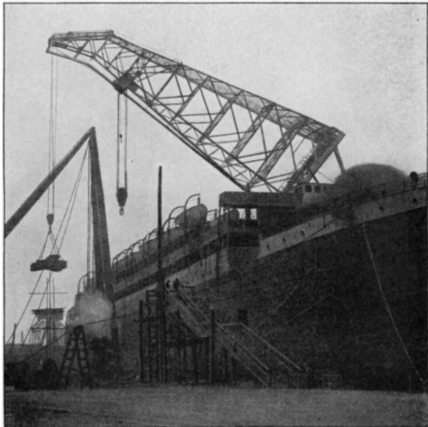
Abb. 724. Scherenkran und Wippdrehkran (Belfast).
