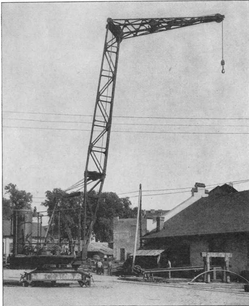
Abb. 756. Fahrbarer Wippdrehkran (S. Marco).
