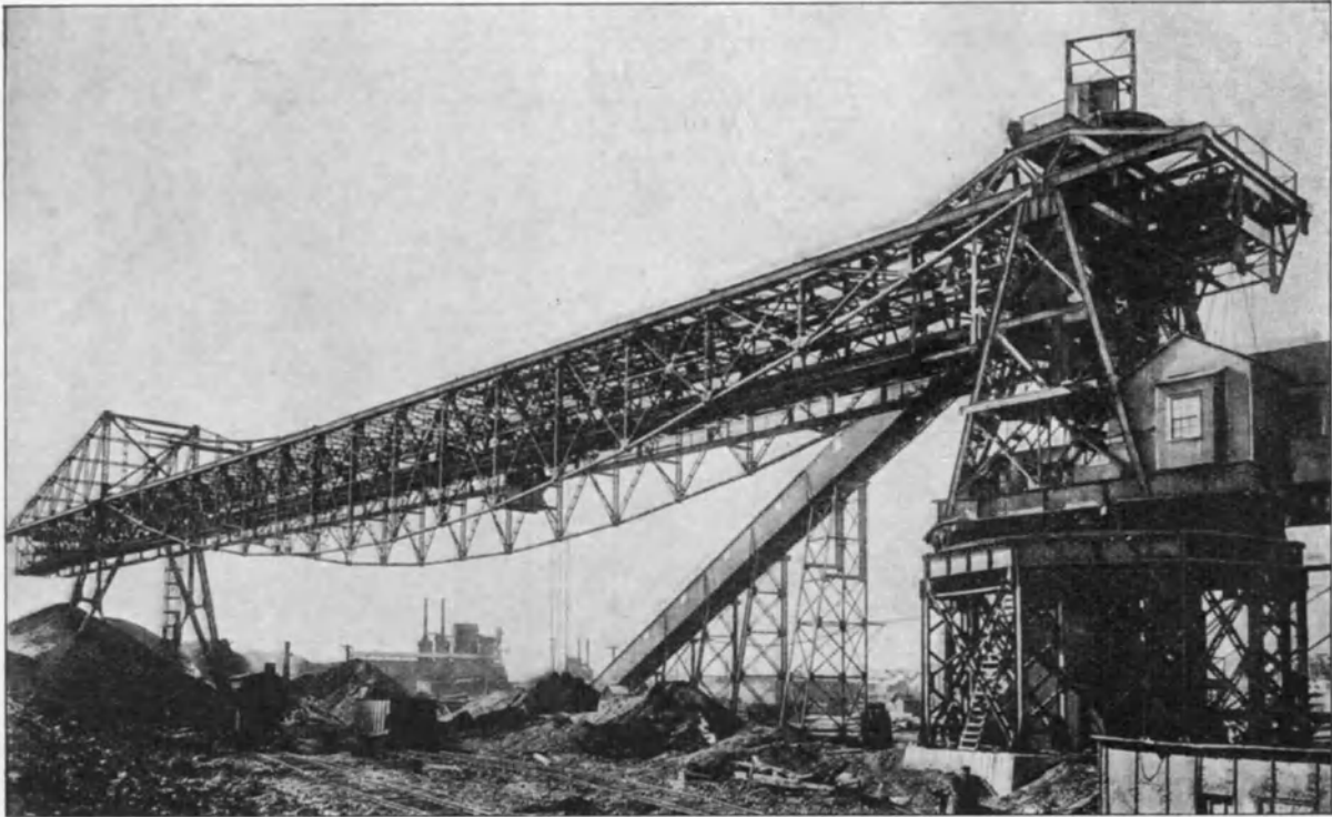
Abb. 956. Schwenkbare Verladebrücke (Milwaukee).
