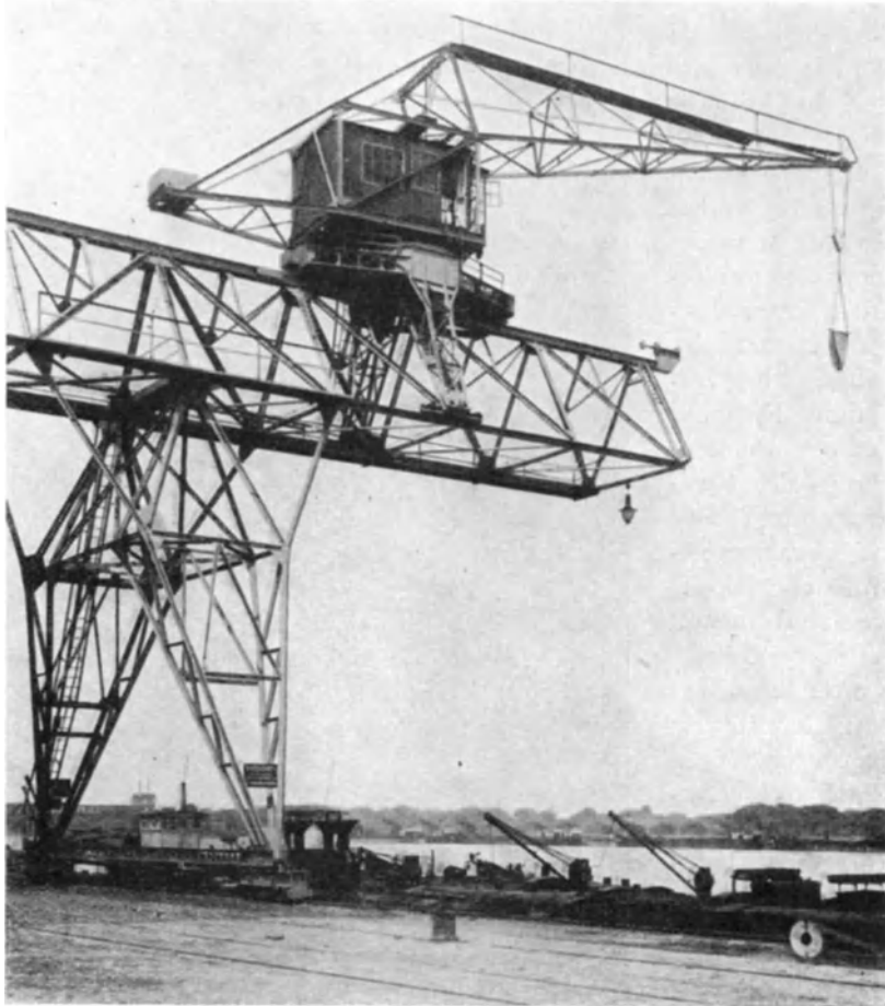
Abb. 863. Verladebrücke mit Reiterdrehkran (Wien).
