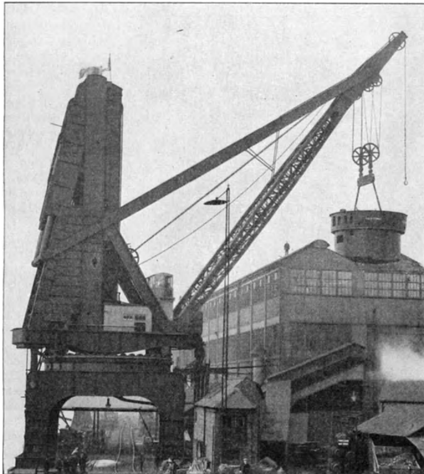
Abb. 672. Hydraulischer Ausrüstungskran (Newcastle).
