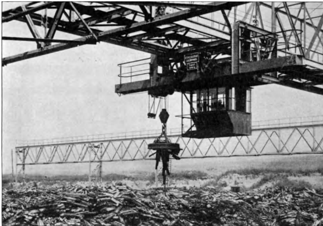
Abb. 217. Magnet. Schrottverladekran (Burbach).
