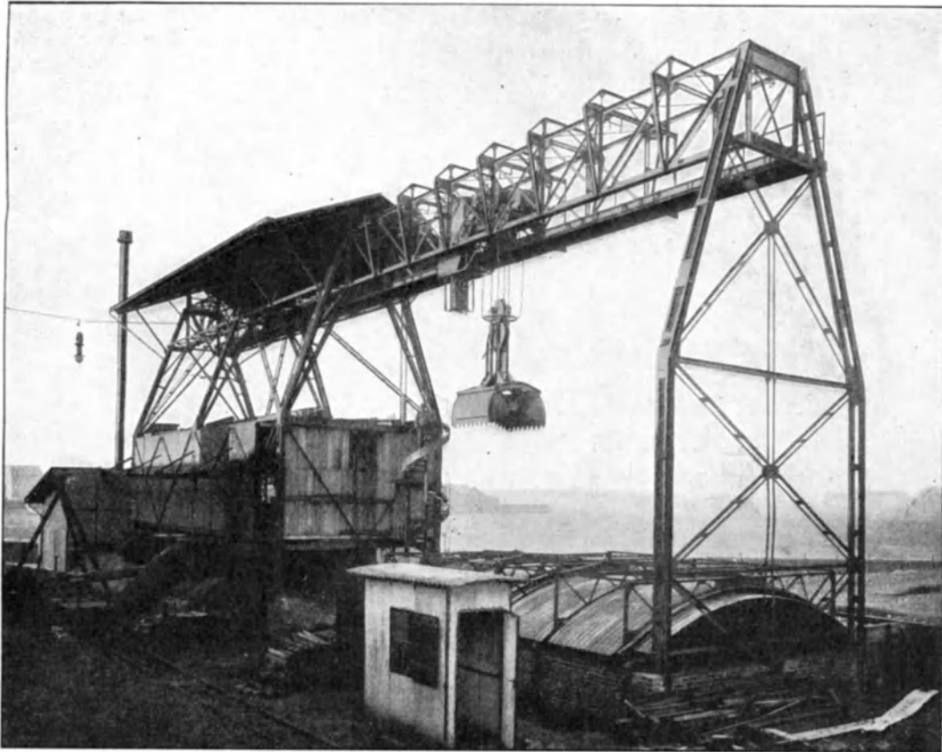
Abb. 251. Generatorenbeschickkatze (Düsseldorf).
