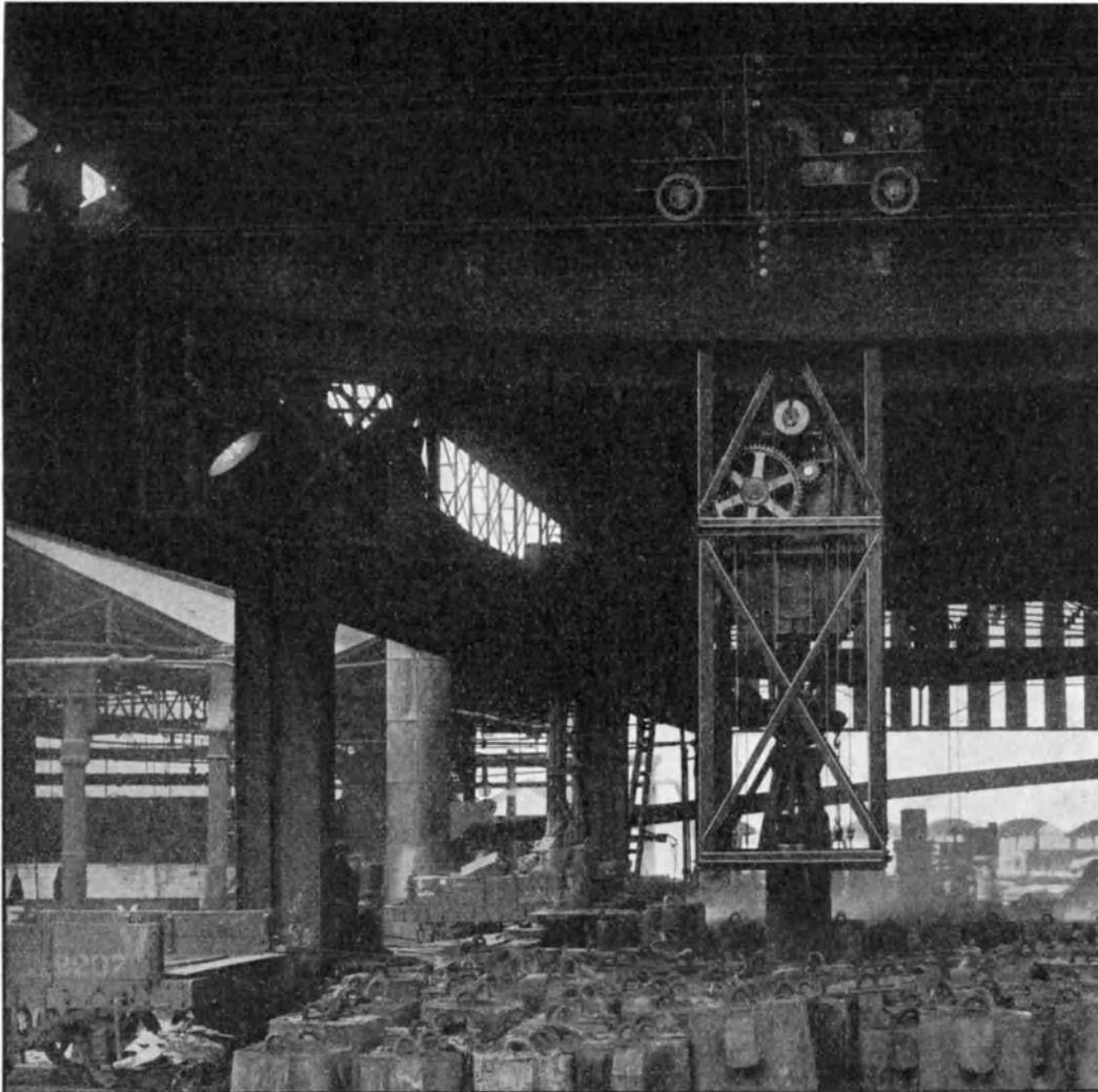
Abb. 356. Elektrischer Stripperkran (Ebbw Vale).
