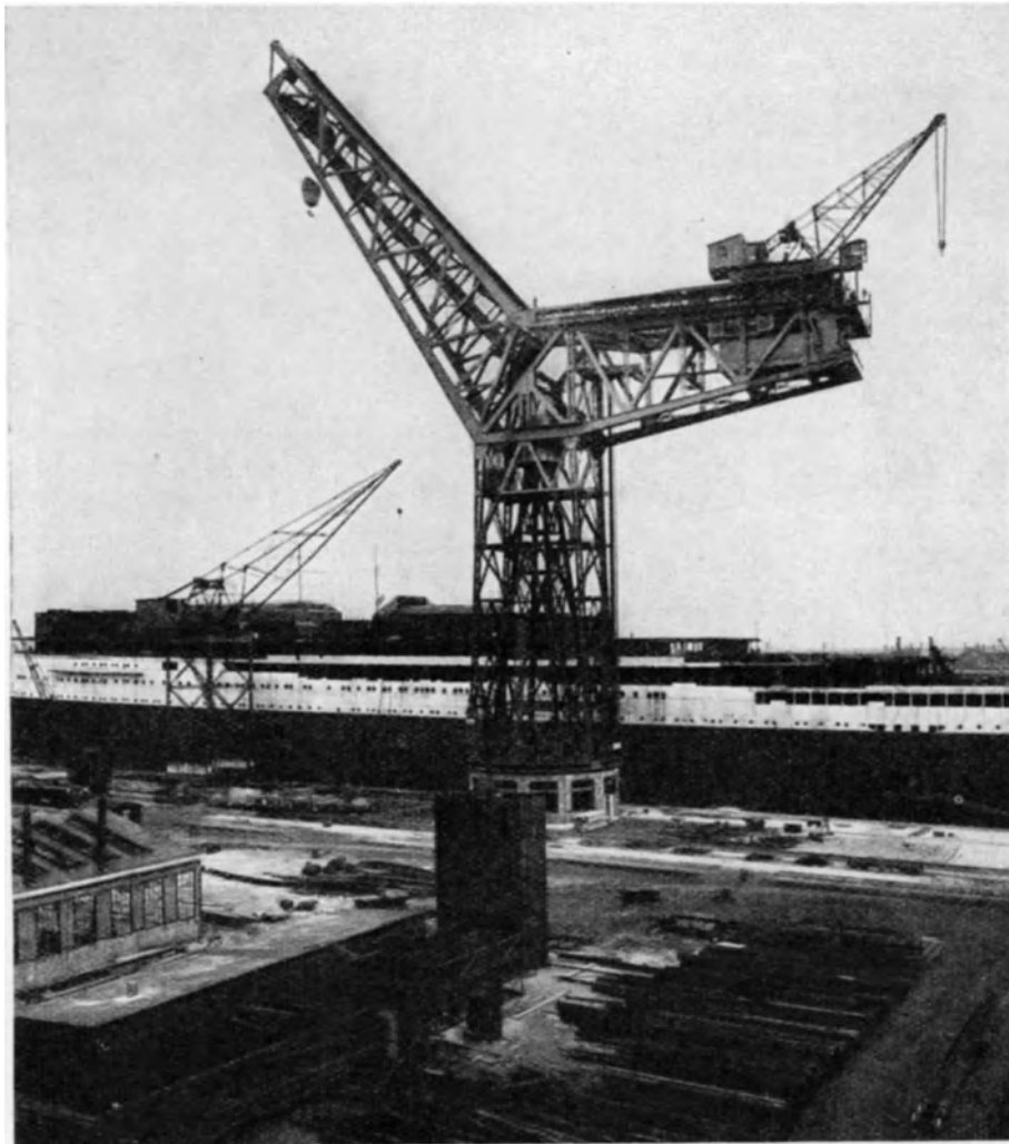
Abb. 697. Hammerwippdrehkran (Hamburg).
