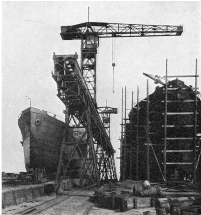
Abb. 593. Fahrbare Hochbahn-Turmdrehkrane (Einswarden).
