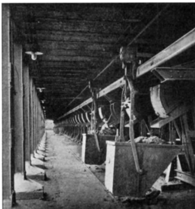
Abb. 100. Gichthängebahn-Füllstation (Neunkirchen).
