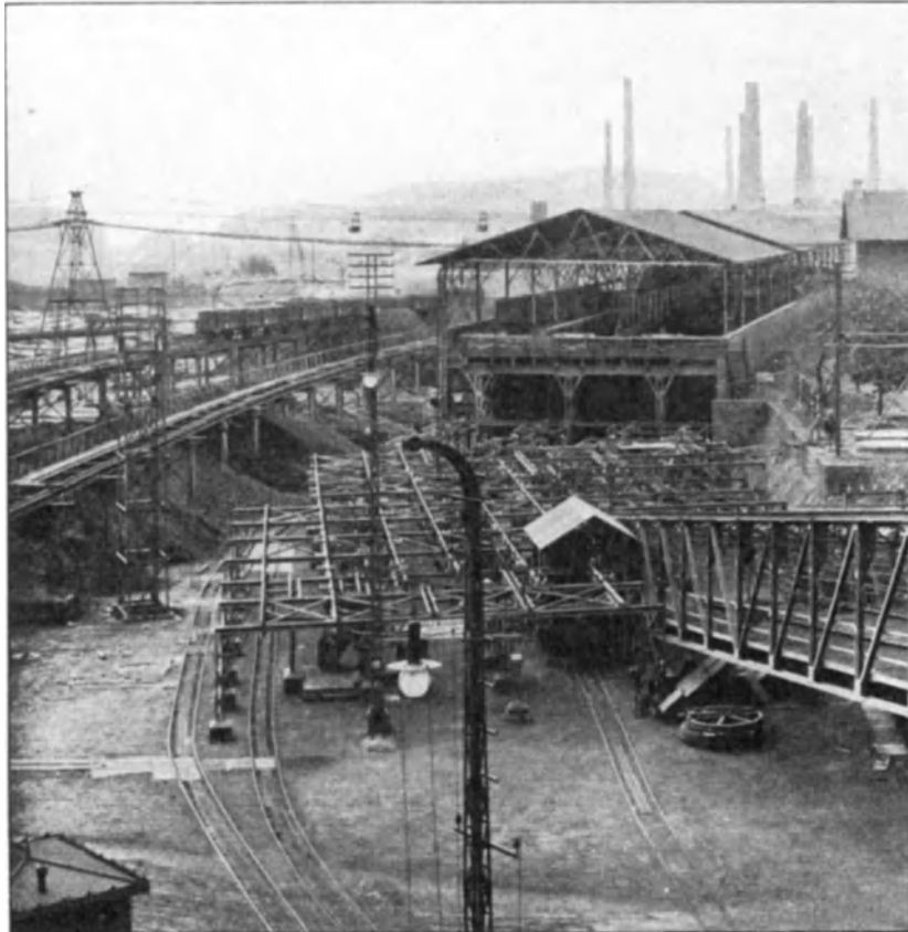
Abb. 101. Aufstellgleise der Hängebahnwagen mit dahinter liegenden Erzbunkern (Neunkirchen).
