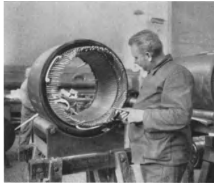
Abb. 184. Zweischichtige Ständer-Stabwicklung während der Herstellung (Werkbild Siemens).
