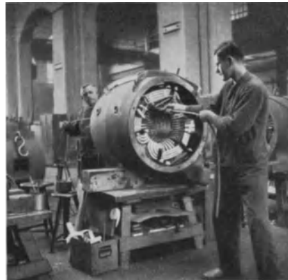
Abb. 171. Einfädelt einer Ständerwicklung (Werkbild Siemens).
