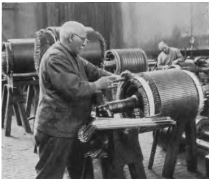
Abb. 189. Zweischichtige Läufer-Stabwicklung während der Herstellung (Werkbild Siemens).
