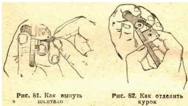
**отделить курок и боевую пружину:** удерживая колодку ударно-спускового механизма так же, как и при отделении шептала, слегка отвести курок назад; вытолкнуть стержнем разобщика ось курка; вынуть ось из колодки; при этом курок отделится от колодки, и боевая пружина свободно выйдет из гнезда (рис. 82);
