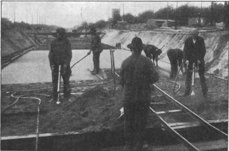
Fig. 96. Einstemmen eines Kanals in eine Wand mittels Druckluftmeißels 1) .
