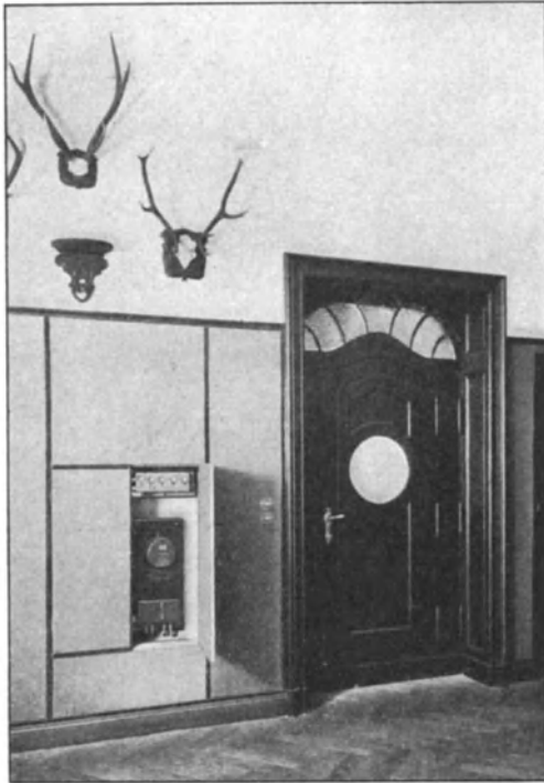
Fig. 13. Verteilungsstelle in der Diele eines Wohnhauses.
