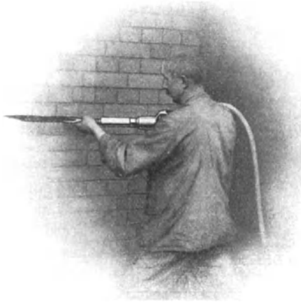
Fig. 96. Einstemmen eines Kanals in eine Wand mittels Druckluftmeißels 1) .
