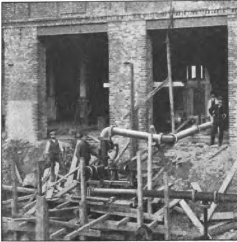
Fig. 89. Grundwasserabsenkung mit elektrisch angetriebener Zentrifugalpumpe.
