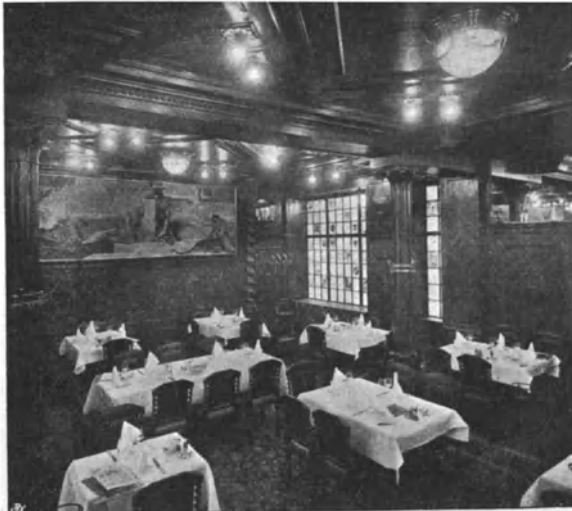
Fig. 48. Deckenbeleuchtung eines Restaurants mit großen Metallfadenlampen in Halbschalen.
