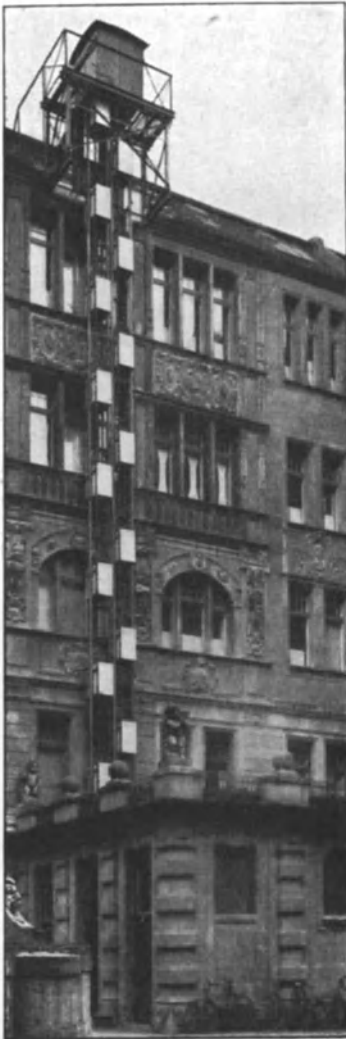
Fig. 75. Paternosteraufzug für Lasten im Hof eines Warenhauses.
