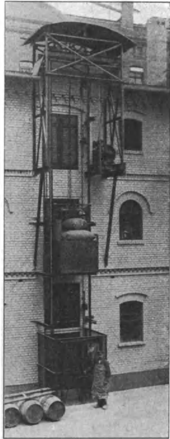
Fig. 74. Lastenaufzug im Hof eines Geschäftshauses 2) .
