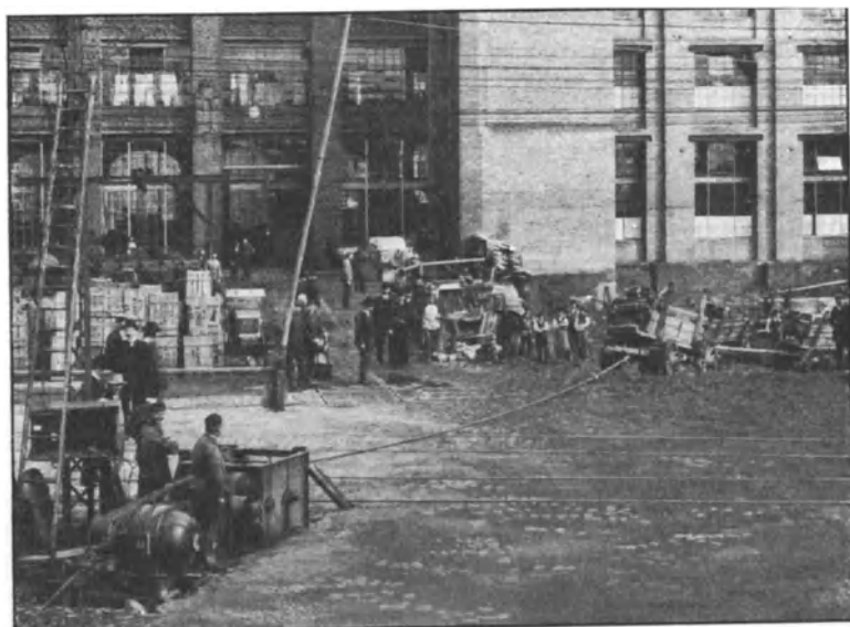
Fig. 88. Ein Lastwagen wird mittels elektrisch betriebener Winde aus der Baugrube gezogen.
