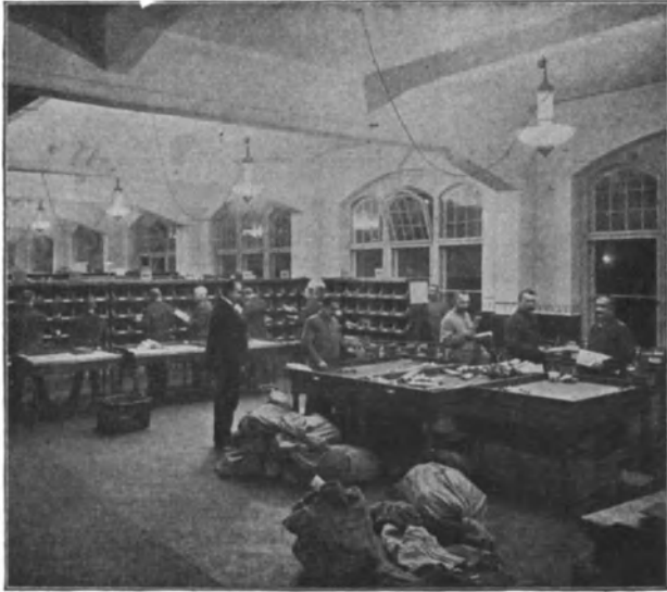
Fig. 53. Beleuchtung eines Briefsortiersaales mit Sparbogenlampen in halbindirekter Anordnung.
