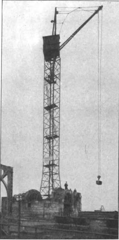
Fig. 92. Turmdrehkran für Baumaterialförderung 1) .
