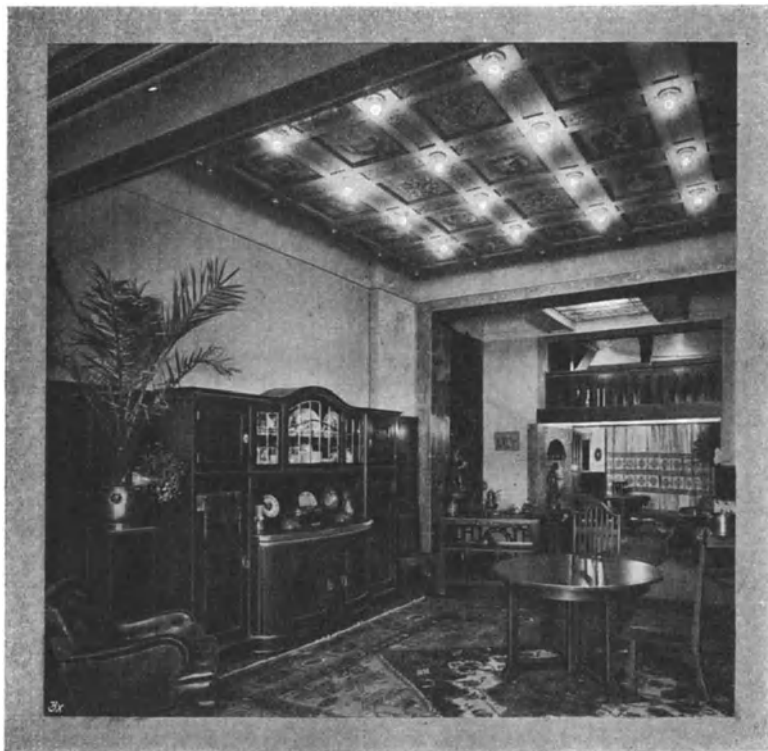
Fig. 49. Beleuchtung eines Speisezimmers mit an der Decke verteilten Metallfadlampen (Kassettenscheinwerfer).
