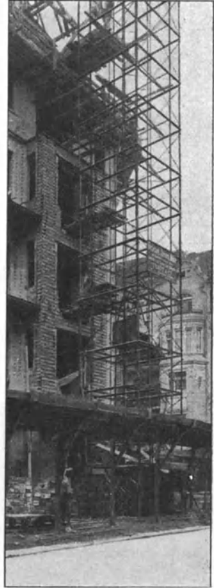
Fig. 93. Elektrisch betriebener Schachtaufzug.
