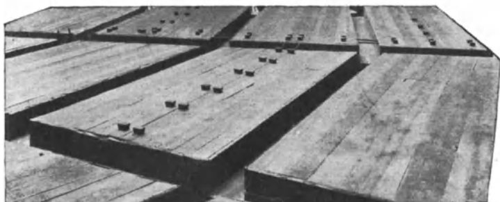
Fig. 9. Holzdecke zur Aufnahme des Eisenbetons mit aufgenagelten Holzdübeln und eingelegten Durchführungsrohren.
