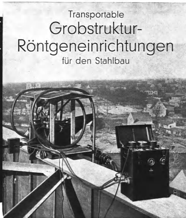
Untersuchung von Schweißnähten am Obergurt einer Brücke
