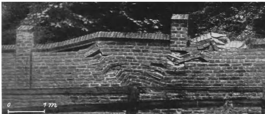
Abb. 24. Verformung einer Ziegelmauer durch Bodenbewegungen nach gleichem Muster wie Abb. 23 (nach W. Schwarz) Aus E. Seidl, Bruch- und Fließformen der technischen Mechanik und ihre Anwendung auf Geologie und Bergbau, Bd. V: Krümmungsformen, Berlin 1934, VDI-Verlag
