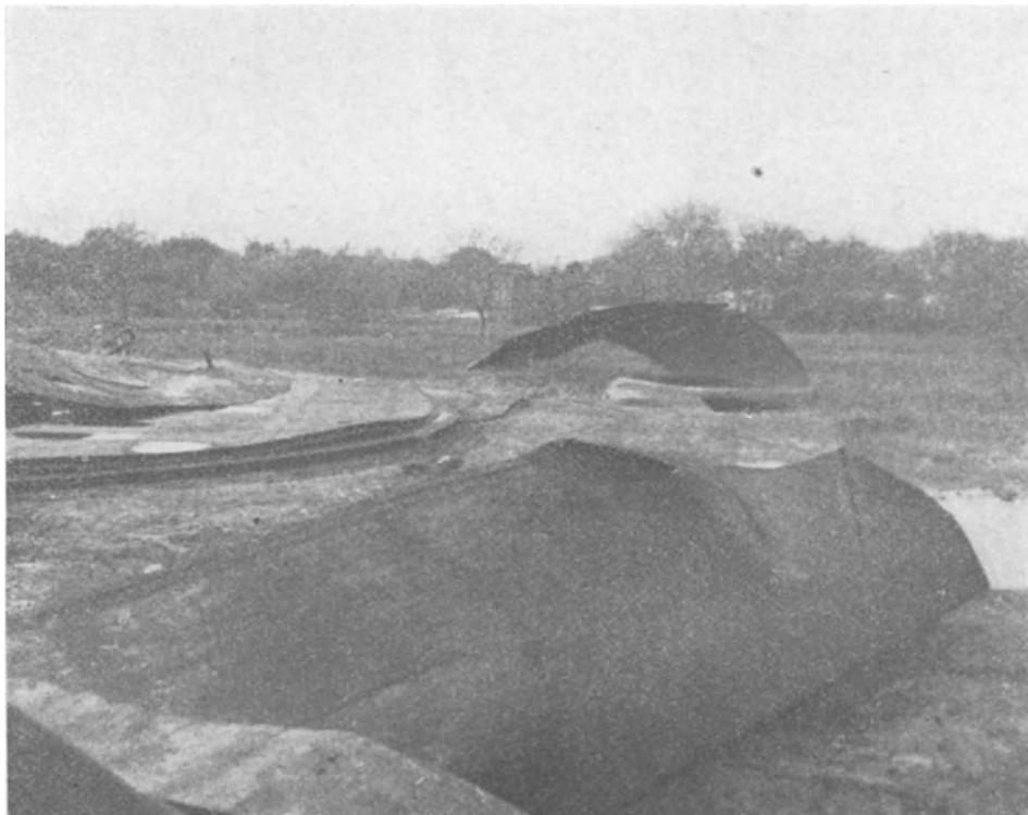
Bild 6. Die drei unteren neben dem Tankboden liegenden Blechschüsse des Tankmantels (siehe Skizze Bild 3), im Hintergrund das Ende b-d.
