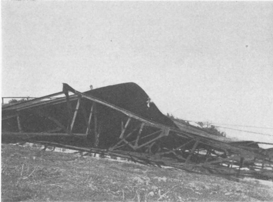
Bild 5. Eingestürzte Tankdecke mit Deckengespärre.
