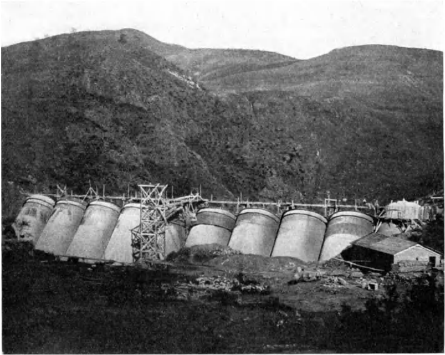
Abb. 251. Piano Sapeio-Sperre im Bau. Bergansicht.
