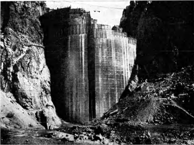
Abb. 156. Montejaque. Bergansicht im Bau.
