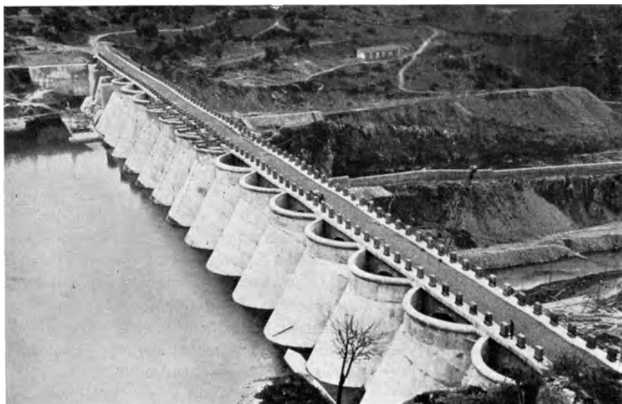
Abb. 235. Tirso. Blick auf die Wasserseite.
