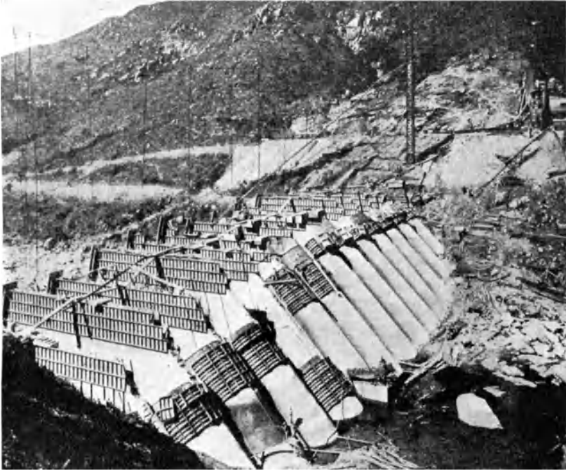
Abb. 184. Lake Hodges-Sperre im Bau.
