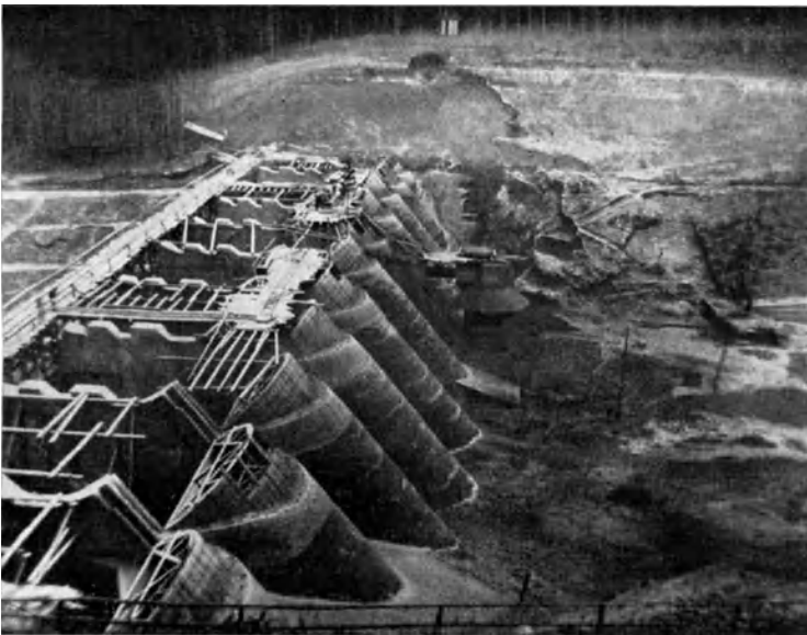
Abb. 258. Vöhrenbach. Bauzustand am 22. Dezember 1924.
