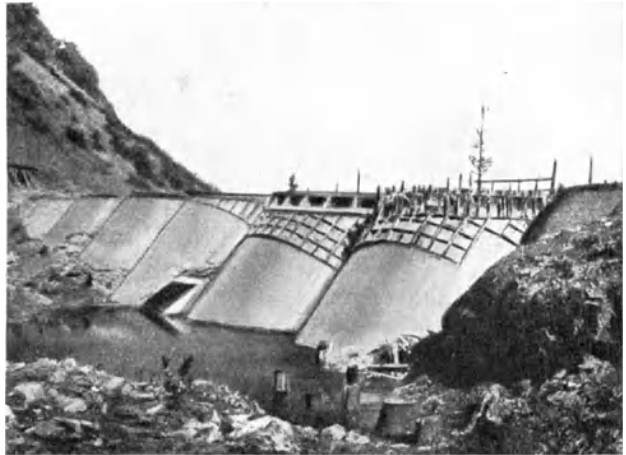
Abb. 197. Agnew-Lake-Sperre im Bau.
