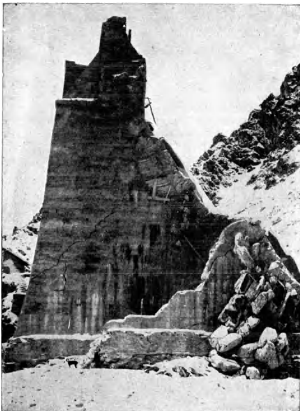
Abb. 293. Gleno. Seitenansicht nach dem Bruch.
