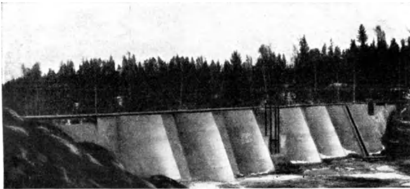
Abb. 270. Melby. Ansicht der Wasserseite.
