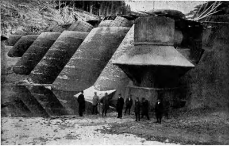
Abb. 259. Vöhrenbach. Die Staumauer mit Entlastungsturm. Der Einstau am 22. Dezember 1924.
