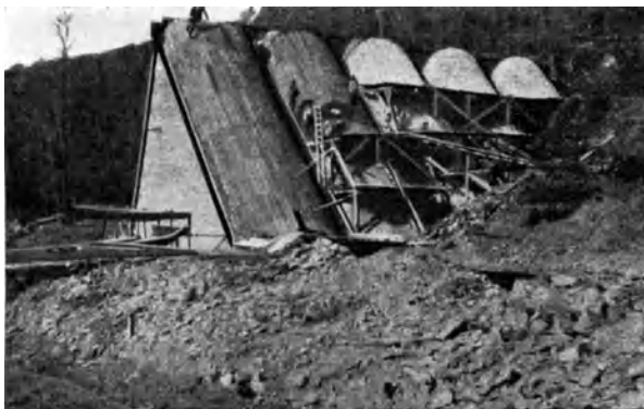
Abb. 266. Belle-Isle-Sperre im Bau. Wasserseite.
