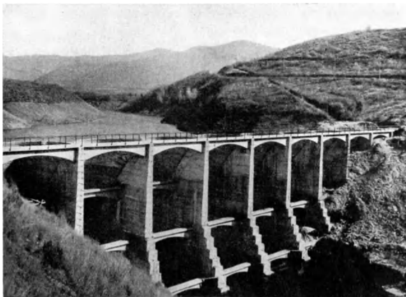
Abb. 199. Mountain Dell-Damm vor Erhöhung. Talansicht.
