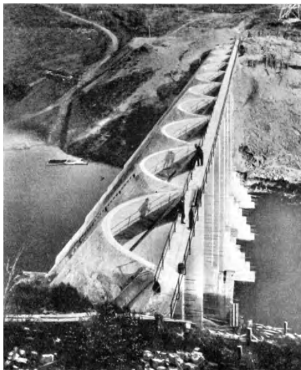
Abb. 200. Mountain Dell-Damm vor Erhöhung. Blick von oben.
