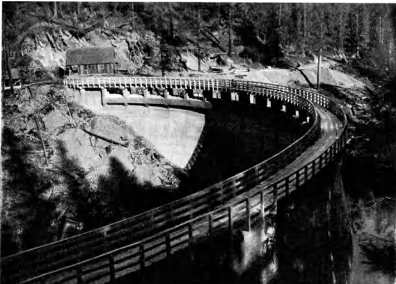
Abb. 145. Lost Creek-Damm mit hölzerner Kronenbrücke.
