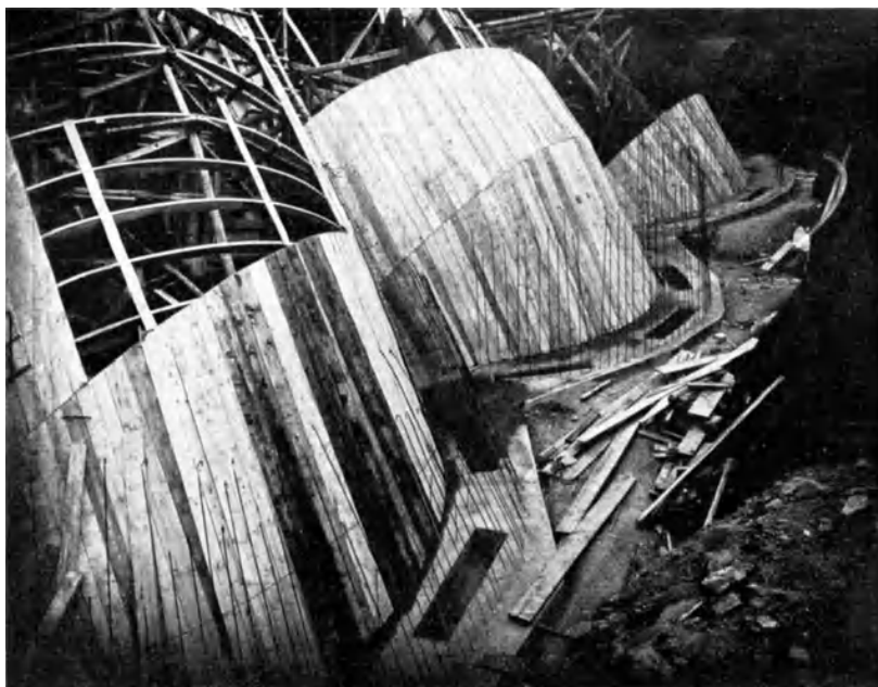
Abb. 256. Vöhrenbach. Herdmaueranschluß an die Gewölbe.
