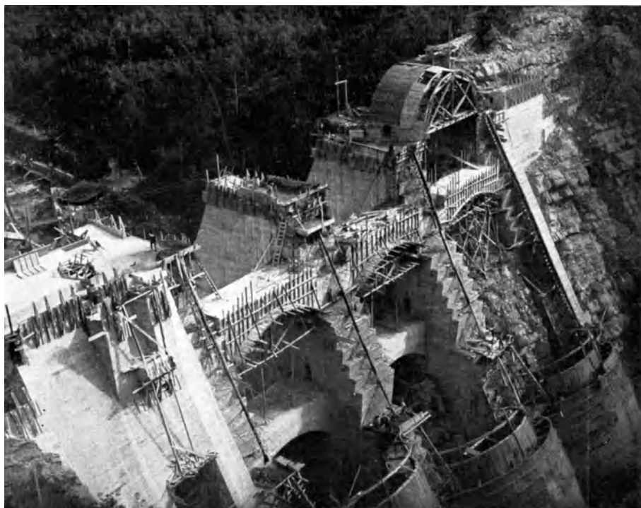
Abb. 244. Pavana. Bau der Gewölbe.
