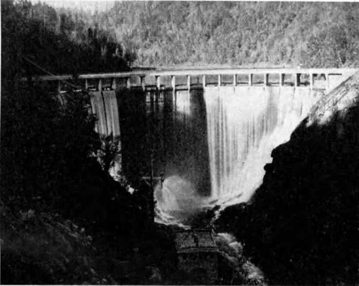
Abb. 146. Bullards Bar-Damm. Größte Überfallmenge 1950 \text{ cbm/sek} .
