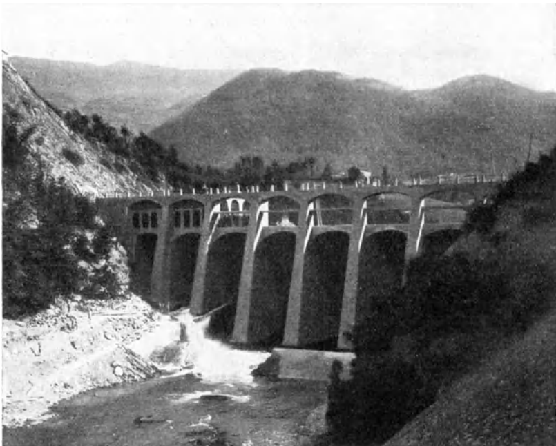
Abb. 223. Scoltenna. Talansicht. (Im Vordergrund das zerstörte Gegenwehr.)
