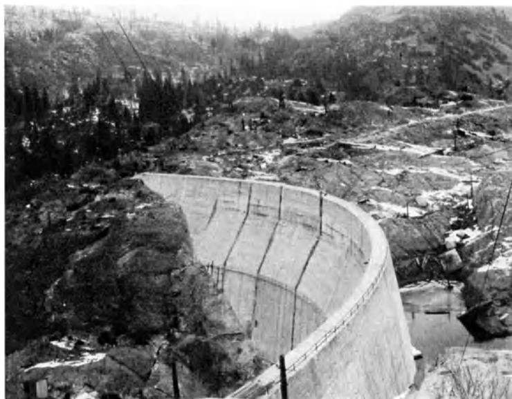
Abb. 140. Lake Spaulding. Endgültiger Zustand.
