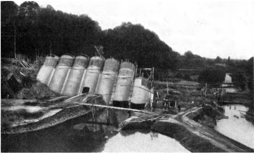
Abb. 263. Sélune-Sperre im Bau. Wasserseite.
