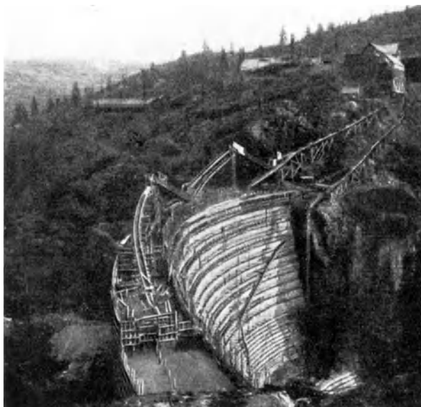
Abb. 139. Lake Spaulding-Damm. Erhöhung und talseitige Verstärkung des Gewölbes.
