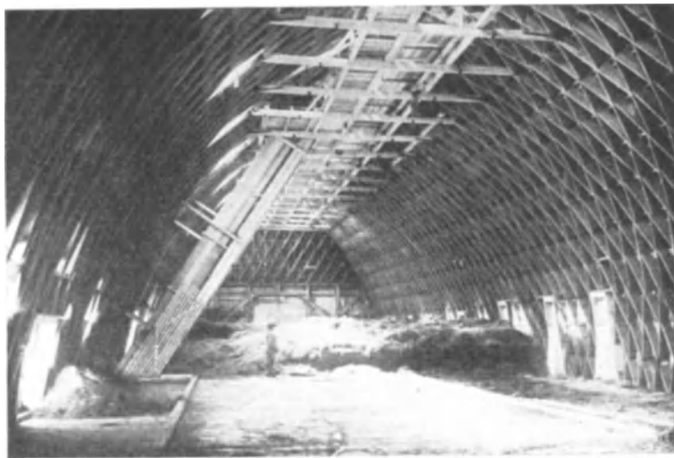
Abb. 254. Innenansicht einer Zollbauscheune mit eingebautem Höhen- und Längsförderer.
