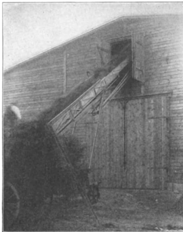
Abb. 211. Beschickung der Scheune von außen durch Stakluke in einem Giebel.
