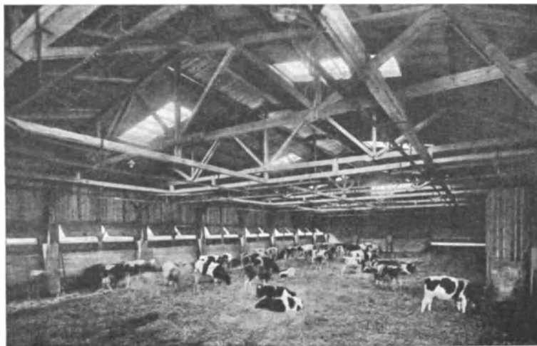
Abb. 84. Innenansicht des Misthauses (an der Längswand die verzinkten Hängekrippen).
