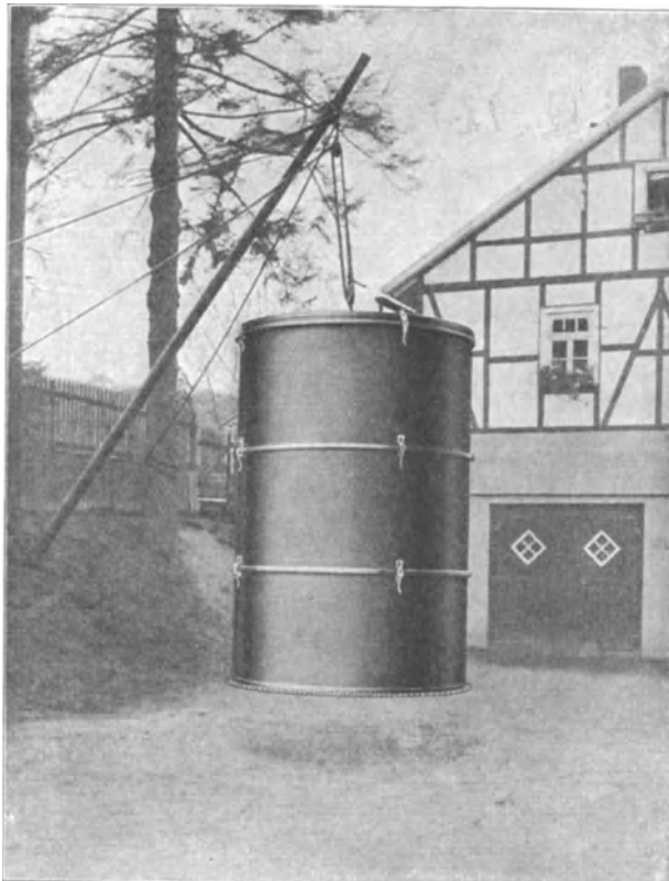
Abb. 344. Metall-Ring-Silo, System Aurich der Firma: Silo- und Kulturtechnik Richard Aurich, Dresden. Aufeinander- setzung der einzelnen Ringe mittels eines Schwenkkranes.
