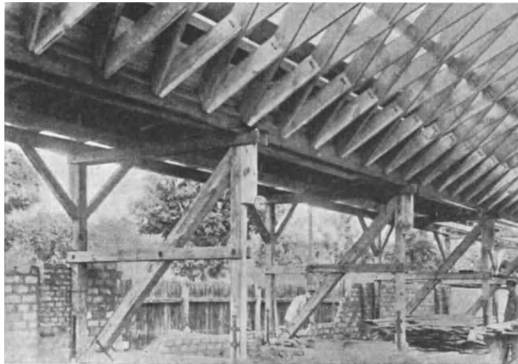
Abb. 252. Knotenpunktausbildung eines in Ausführung befindlichen Zollbaudaches.
