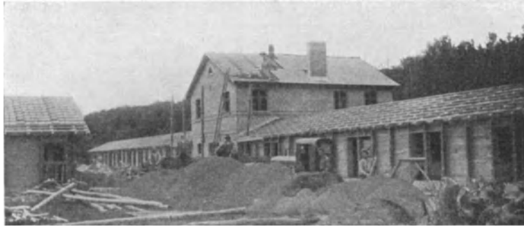
Abb. 159. Schweinezucht- und Mastanlage Osterholz bei Stendal im Bau. (Ausführung: Arthur Müller, Land- und Industriebauten G. m. b. H., Berlin.)
