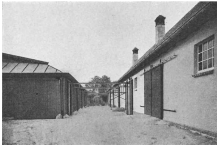
Abb. 86. Straße zwischen Vieh- und Misthaus mit Hängebahnüberquerung.
