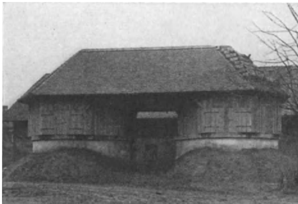
Abb. 332. Zwei Futtertürme mit feststehender, gemeinsamer Überdachung auf Rittergut Gutzeit, Gr.-Gnie, Ostpr.
