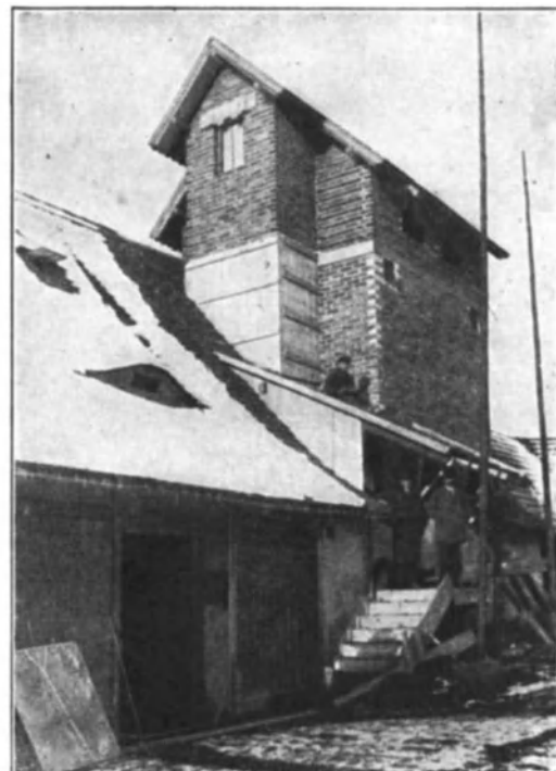
Abb. 292. Eingebautes Ranksches Lüftsilo der Gutsverwaltung Sobětice.
