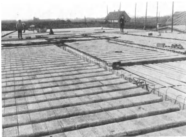
Abb. 106. Stallgebäude in Connhausen. Ausführung der Bimsbetonhohlkörperdecken.
