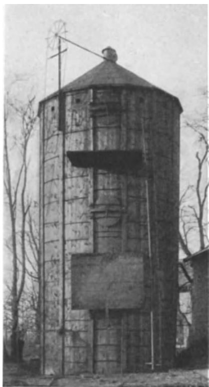
Abb. 311. Schaubild eines ausgeführten Holzsilos „Podeus“ der Maschinenfabrik Podeus A.-G., Wismar i. Meckl.
