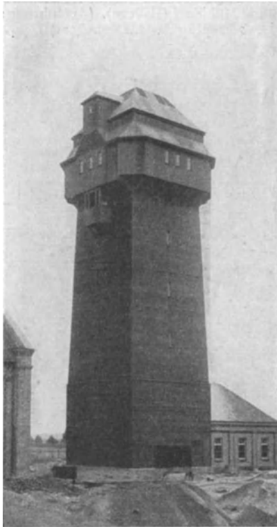
Abb. 423. Hölzerner Wasserturm mit eisernem Behälter von 80 m 3 Inhalt. (Rechts das Pumpenhaus.)
