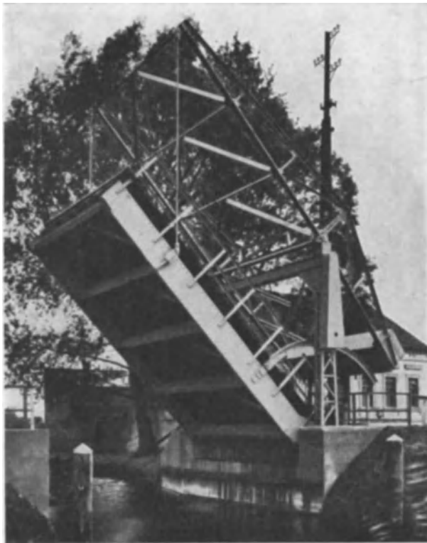
Abb. 420. Zugbrücke bei Ketzin in geöffnetem Zustande.
