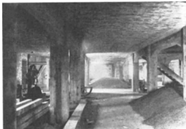
Abb. 277. Getreidespeicher Gutzeit in Groß-Gnie. Blick in das Innere eines Bodens.
