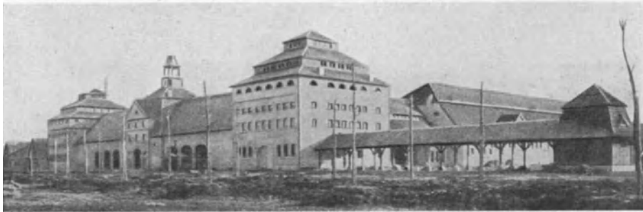
Abb. 16. Gutshof Hahnenmoor. Ansicht der Nordfront mit Dreschtürmen und Torgebäude. Im Erdgeschoß des westlichen Dreschturmes Kunstdüngerraum mit Durchfahrtstenne, im ersten und zweiten Stock Kornböden, darüber im Dachboden Dreschanlage mit reichlicher Belüftung. Rechts vorne Wagenschuppen.
