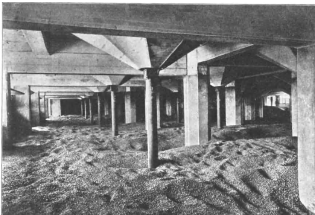
Abb. 273. Getreidespeicher Danzig. Ungeteilter Trichterboden.
