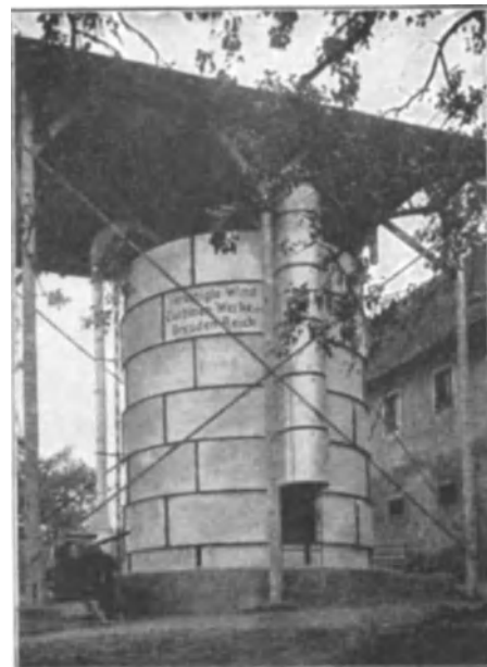
Abb. 347. „Herkules“-Silo, 5 m Durchmesser, 6,30 m Höhe mit Holzdach.
