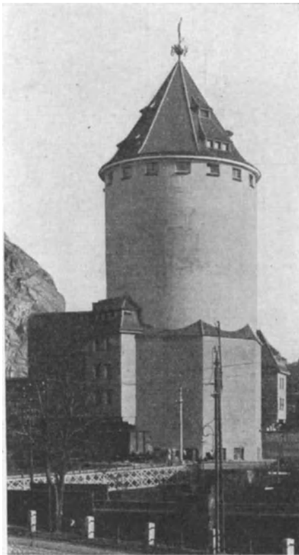
Abb. 288. Getreidesilo in Dölzchen bei Dresden. Gesamtansicht.
