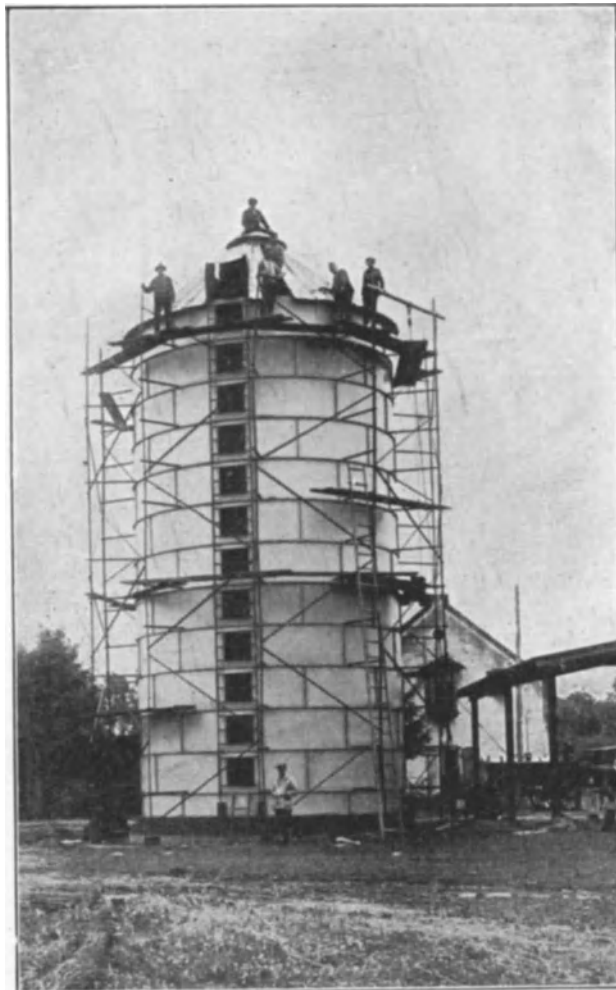
Abb. 351. „Deutschland“-Stahlhochsilo im Bau.
