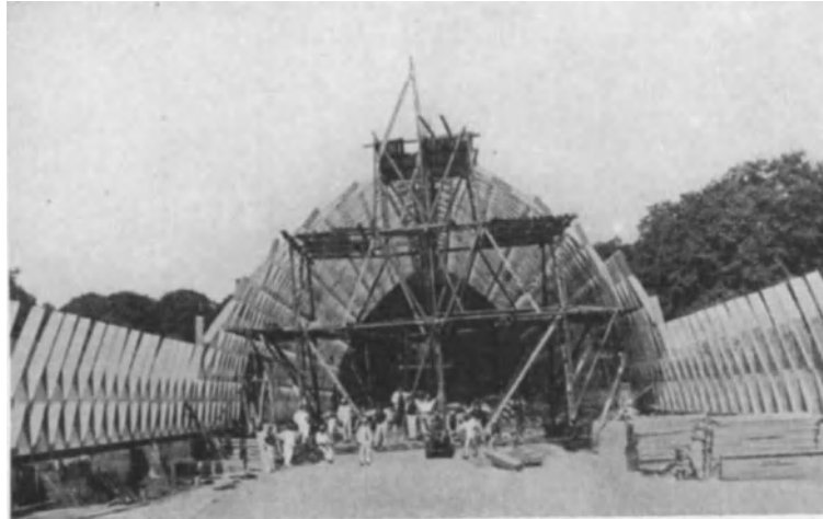
Abb. 253. Scheune in Dänemark während des Aufbaues mittels dreistöckiger fahrbarer Rüstung.
