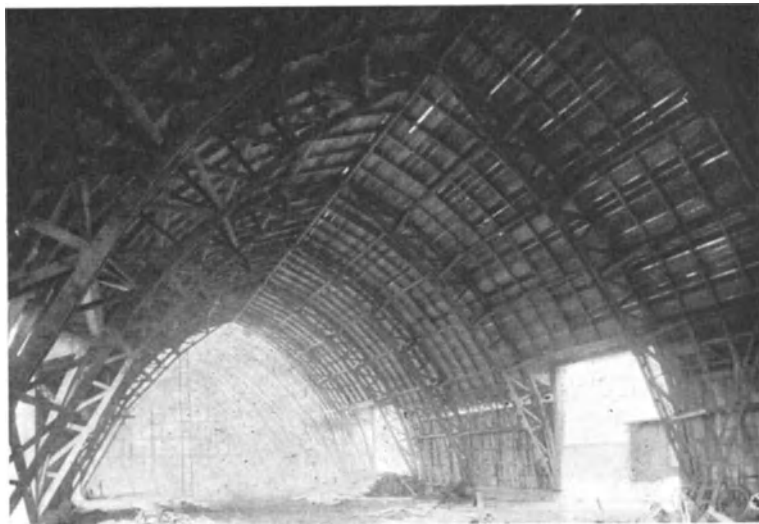
Abb. 242. Feldscheune Nürnberg-Langwasser. Innenansicht während der Ausführung.
