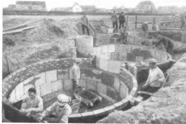
Abb. 343. Ausführung einer Siloanlage nach Bauweise Pfister.
