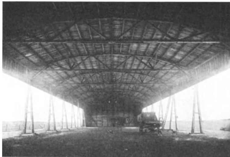
Abb. 232. Scheune auf Gut Hoebeck. Innenansicht nach Fertigstellung.
