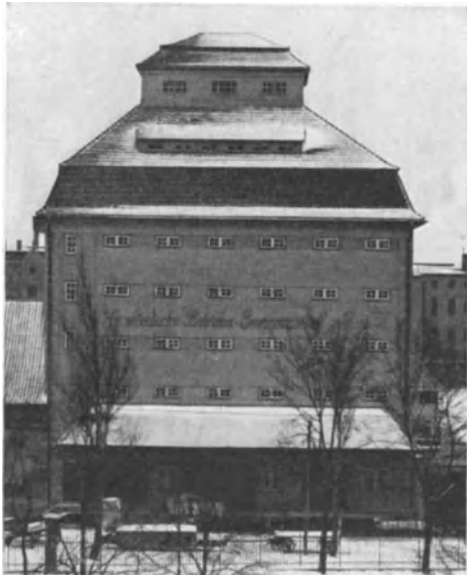
Abb. 304. Getreidespeicher Allenstein. Ansicht von der Straßenseite.
