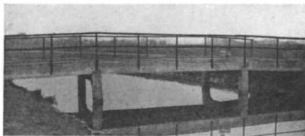
Abb. 414. Feldbrücke über das Hooksier Tief auf dem Landgut Klaiburg. Schaubild.
