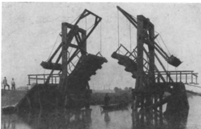
Abb. 417. Zugbrücke in Milow in geöffnetem Zustande.
