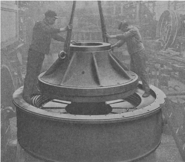
Abb. 116. Voith-Spurlager für 502000 kg Belastung während der Werkstattmontage.
