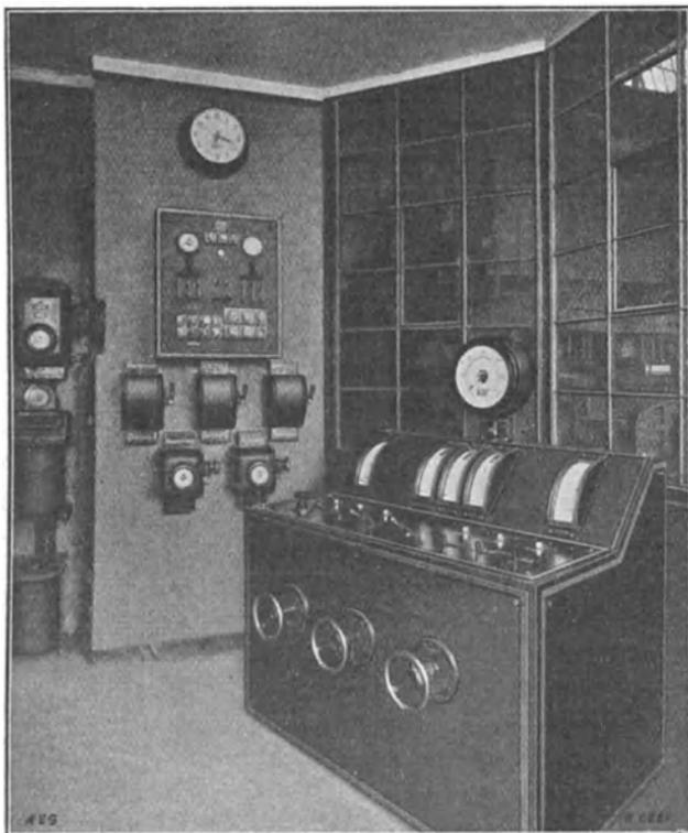
Abb. 94. Schaltpult einer Lichtbogenofenanlage.
