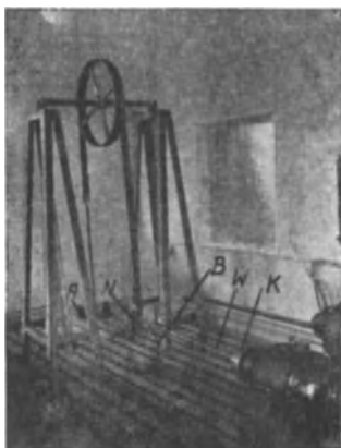
Abb. 46. Biegeeichvorrichtung.
