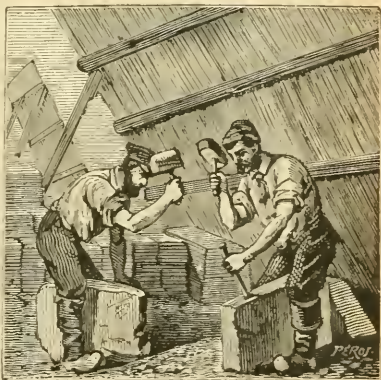
ARDOISIERS D'ANGERS. — Quand les ardoises ont été arrachées de la carrière par gros blocs, on les fend au moyen de coins et de pics; on obtient ainsi des feuilles de plus en plus minces. De nos jours, on a inventé une machine au moyen de laquelle on fend les ardoises avec rapidité.
