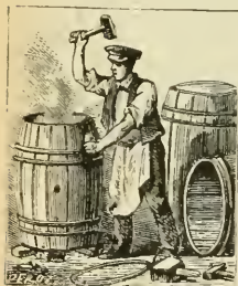
LE TONNELIER. — Pour rendre plus flexibles les douves qu'il veut recourber et assembler, le tonnelier allume dessous un feu de copeaux. Ensuite il les entoure de cerceles en bois ou en fer.
