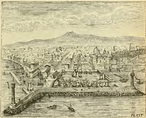
MARSEILLE ET SES PORTS. — Marseille, le premier port de France, est une ville excessivement commerçante et industrielle de 491 200 habitants. Dans ses ports, que protègent de longues jetées, se rendent par milliers des vaisseaux venus de tous les points du globe. Elle fait un très important commerce avec l'Algérie et la Tunisie. Enfin, ses ateliers produisent une grande quantité d'objets de toute sorte ; ses seules savonneries donnent plus de 100 millions de kilogrammes de savon par an.
