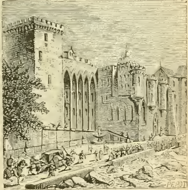
AVIGNON ET LE CHATEAU DES PAPES. — Avignon (46 900 hab.), ancienne capitale du comtat Venaissin, sur le Rhône, servit autrefois de résidence aux papes. On y voit encore leur palais, majestueux monument du quatorzième siècle.
