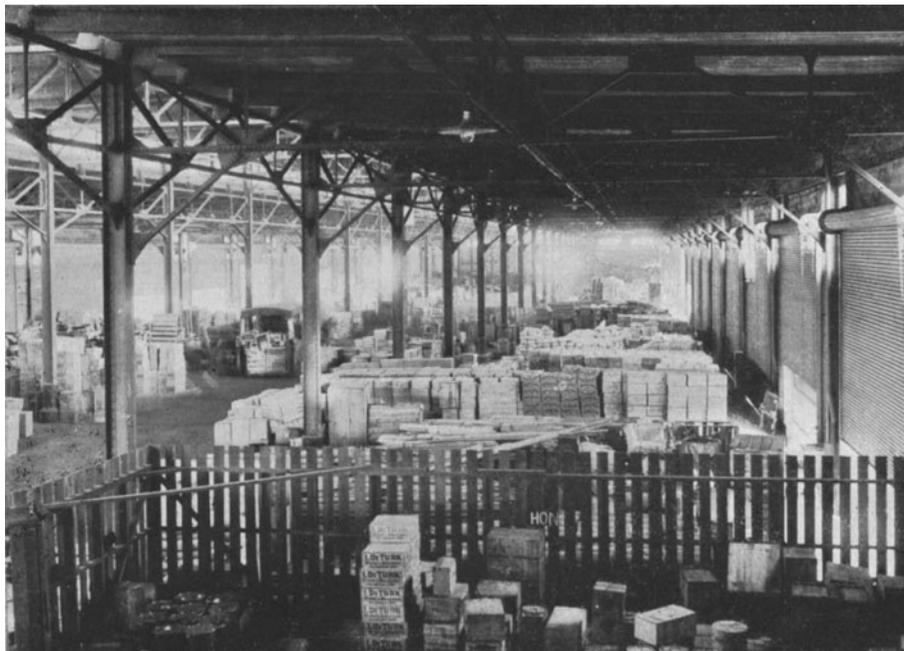
Fig. 73. Transitschuppen auf Pier 30 mit in Wellenblechjalousien aufgelösten Seitenwänden.
