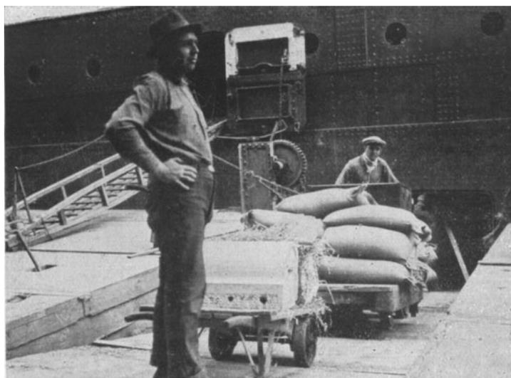
Fig. 72. Versenkbare Zugbrücke für die Seitenfortenbearbeitung mit Handtrucks bzw. Elektrokarren.
