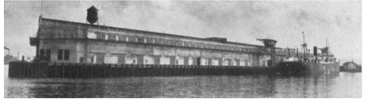
Fig. 105. Pierschuppen mit umlaufender Schwebbahn.
