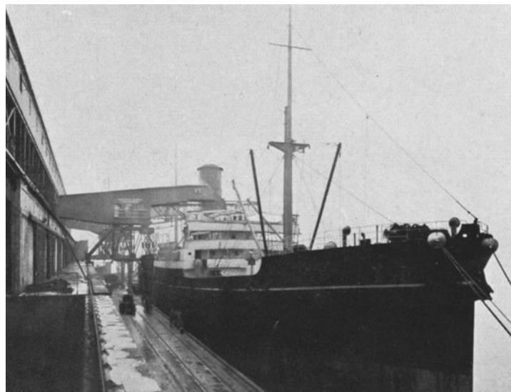
Fig. 130. Universalkran am Ballantyne-Pier (in Stellung für Getreideförderung aus Verteilerkanal über Band im Ausleger nach Schiff).
