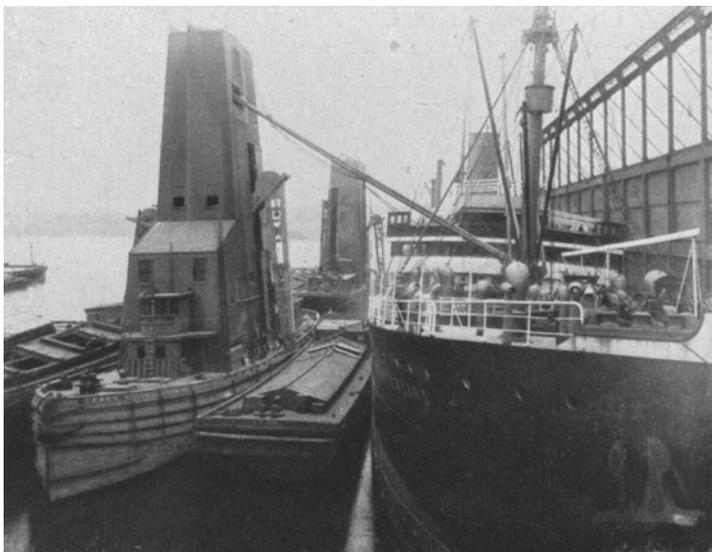
Fig. 179. Mit doppelseitigen Becherwerken versehener schwimmender Getreideheber.
