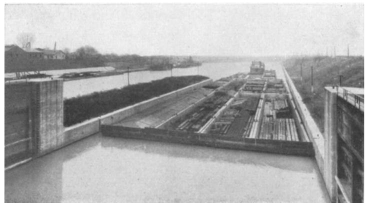
Fig. 150. Schiebeschleppzug, in eine Monongahela-Schleuse hineinmanövrierend.
