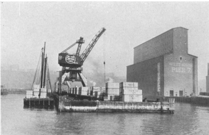
Fig. 155. Vollportalkran auf einem offenen Eisenbahnpier.
