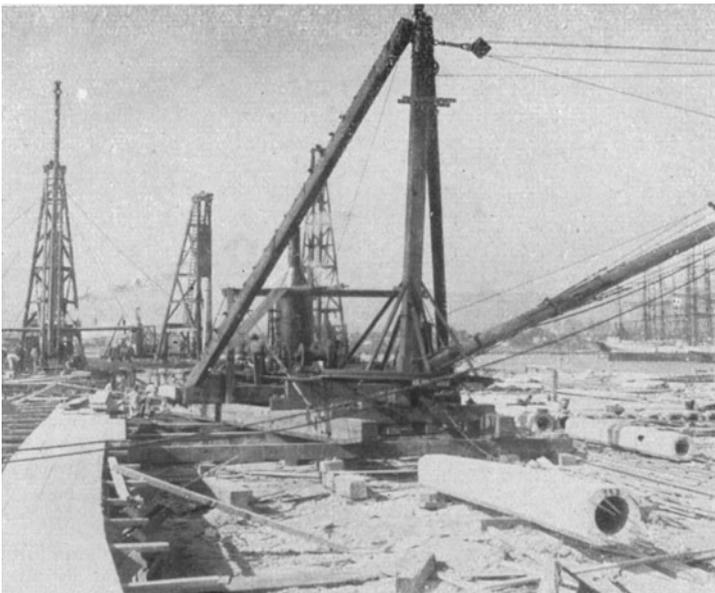
Fig. 65. Betonbementelte Pfähle beim Pierbau in Alameda.
