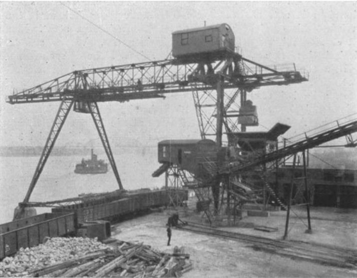
Fig. 145. Kies-Empfangsanlage der Ohio River Sand Co.
