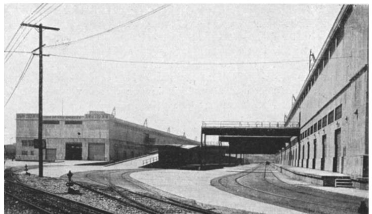
Fig. 42. Zweigeschossige Transitschuppen auf neuerbautem Pier an der Ostfront des Hauptkanals mit Schrägrampe und Querbrücken für den Lastauto-Verkehr in den oberen Stockwerken.
