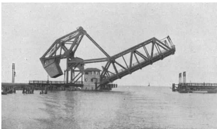
Fig. 26. Klappbrücke über den Inner Navigation Canal (nördlichste Brücke unmittelbar am Lake Pontchartrain).
