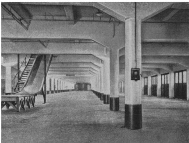
Fig. 128. Untergeschoß des zweigeschossigen Beton-Pierschuppens des Ballantyne-Piers.
