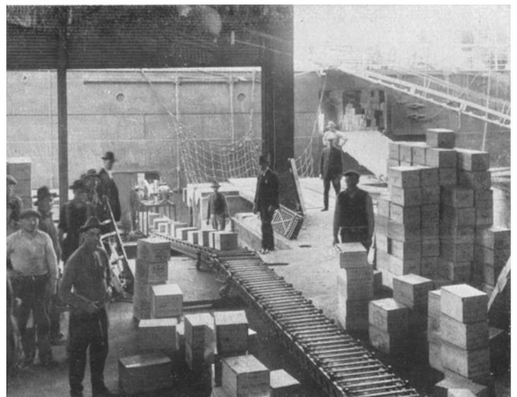
Fig. 70. Elektrischer und Schwergewichts-Horizontalförderer für Bearbeitung von Seitenpforten.
