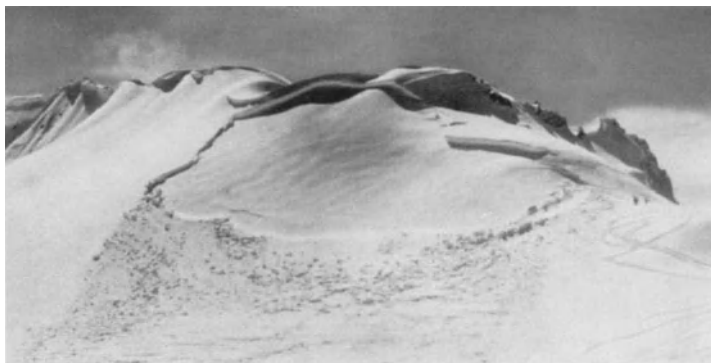
Abb. 83. Oben unter der Wächte Gegenböschung; in halber Hanghöhe in Schneeschild übergehend. Packschnee auf Lee. Gegenböschungslawine am Schindler.
