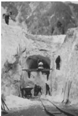
Abb. 115. Durchtunnelung einer nassen Firnschneelawine auf der Grimselstraße. (Photo: Grimselwerk.)
