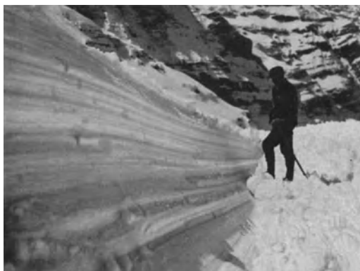
Abb. 112. Eigerlawine. c. Linksseitige Scherfläche, welche in die waagerechte untere Gleitfläche übergeht und von den vorbeigeschleiften Knollen und mitgerissenen Eisblöcken tiefe Furchen zeigt und hart gepreßt ist. (Photo: Paulcke.)
